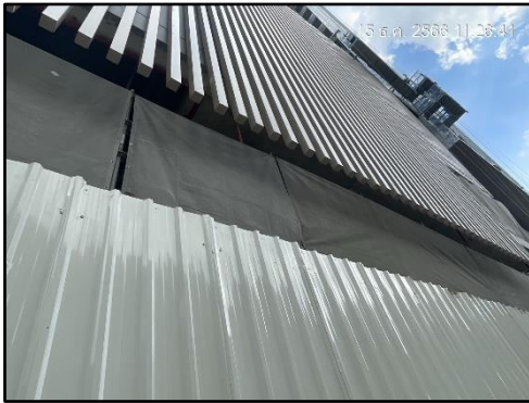
รูปที่ 12 ผ่าใบกันฝุ่นคลุมอาคาร
