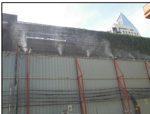
รูปที่ 3 นีดสปริงเกอร์และฉีดพรมน้ำบริเวณก่อสร้างหรือบริเวณที่ทำให้เกิดฝุ่น
