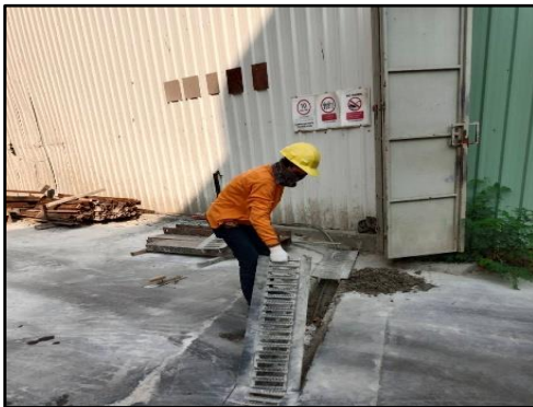
รูปที่ 36 ท่อระบายน้ำชั่วคราว โดยรอบพื้นที่โครงการ
