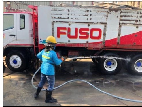
รูปที่ 18 ทำความสะอาดล้อรถบรรทุกวัสดุก่อสร้างภายในพื้นที่โครงการ
