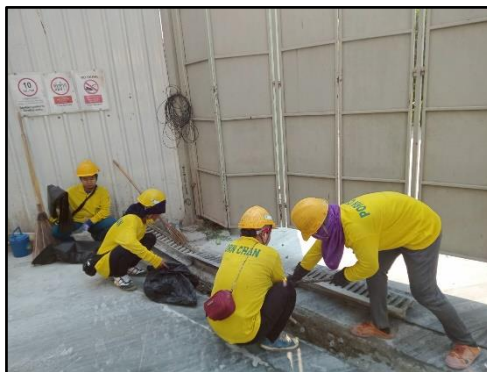
รูปที่ 37 เจ้าหน้าที่ดูแลขุดลอกตะกอนที่สะสมในท่อระบายน้ำชั่วคราว
