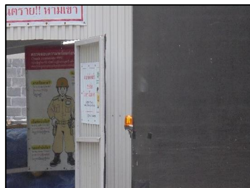
รูปที่ 56 การติดตั้งป้ายสัญญาณไฟเตือน ไฟกระพริบ
