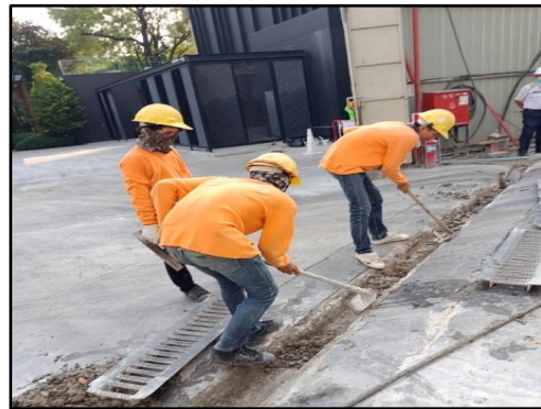
รูปที่ 36 ท่อระบายน้ำชั่วคราว โดยรอบพื้นที่โครงการ
