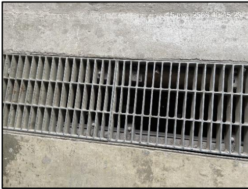
รูปที่ 36 ท่อระบายน้ำชั่วคราว โดยรอบพื้นที่โครงการ
