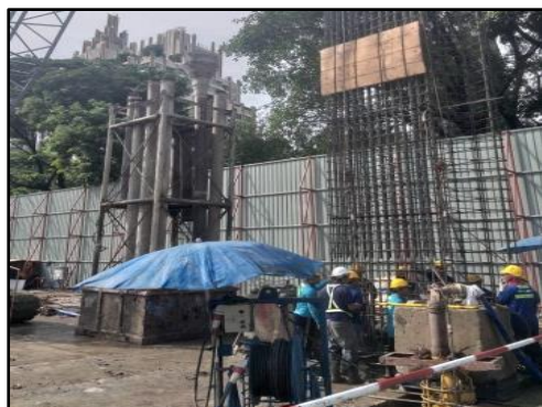
รูปที่ 27 การก่อสร้างกำแพงกันดิน (D-Wall)
