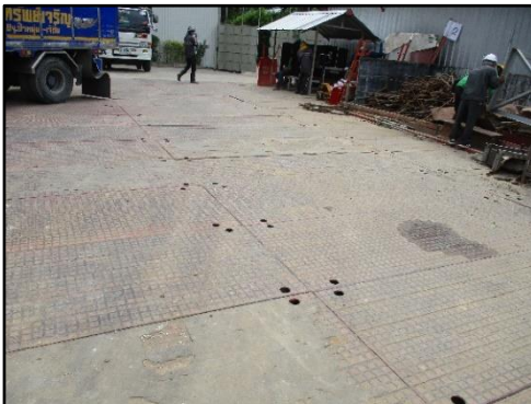
รูปที่ 19 แผ่นเหล็กอย่างหนาปูภายในพื้นที่โครงการ
