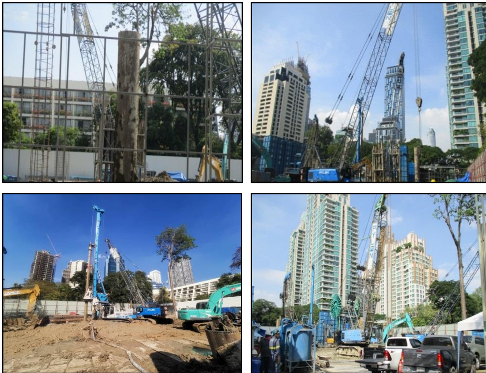
รูปที่ 23 การใช้เสาเข็มแบบเจาะในการก่อสร้างเพื่อลดผลกระทบด้านเสียงและการสั่นสะเทือน
