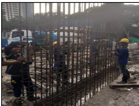
รูปที่ 27 การก่อสร้างกำแพงกันดิน (D-Wall)
