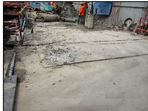
รูปที่ 19 แผ่นเหล็กอย่างหนาปูภายในพื้นที่โครงการ
