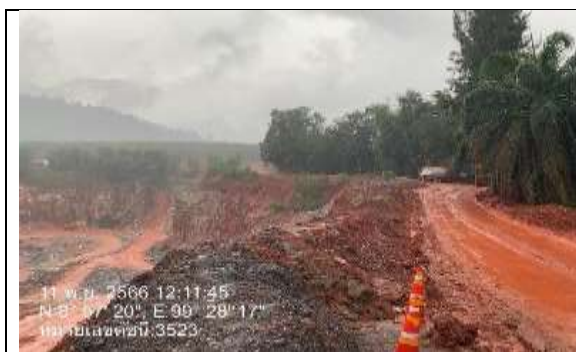
รูป Q สร้างคันทำนบความกว้างฐาน 5 เมตร สูง 3 เมตร และสันคันด้านบนกว้าง 2.5 เมตรพร้อมปลูกพืชคลุมดิน
