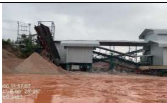
รูป W สร้างอาคารปิดคลุม Hopper, Primary Crusher และตระแกรงคัดขนาดแร่ พร้อมทั้งติดตั้งระบบสเปรย์น้ำ
