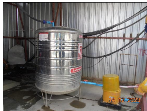
รูปที่ 53 ถังสำรองน้ำใช้ในพื้นที่ก่อสร้างโครงการ
