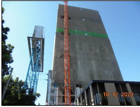
รูปที่ 4 ติดตั้ง Mesh Sheet รอบอาคาร
