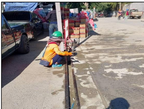
รูปที่ 54 ทำความสะอาดท่อระบายน้ำ
