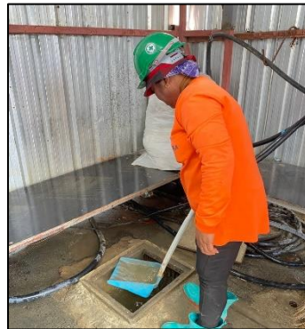
รูปที่ 50 เจ้าหน้าที่ตรวจสอบปริมาณตะกอนดินในบ่อพัก และขุดลอกอย่างสม่ำเสมอ
