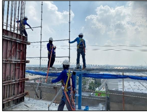
รูปที่ 94 อุปกรณ์ป้องกันอันตรายจากการพลัดตกหล่นจากที่สูง
