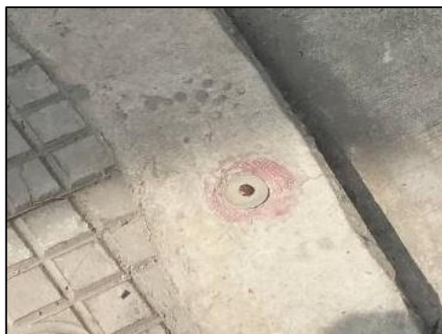
รูปที่ 71 หมุดระดับ และพิกัดอ้างอิงภายในพื้นที่ก่อสร้าง
