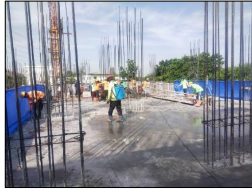
รูปที่ 80 พนักงานทำการบ่มคอนกรีต ด้วยการฉีดพ่นน้ำยา
