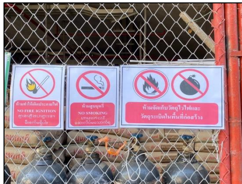
รูปที่ 82 พื้นที่จัดเก็บวัสดุไวไฟ และป้ายห้ามก่อให้เกิดประกายไฟภายในพื้นที่จัดเก็บ
