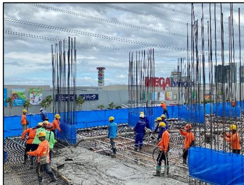
รูปที่ 73 วิศวกรควบคุมงานเทคอนกรีต
