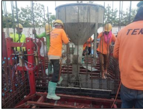
รูปที่ 76 พนักงานเทคอนกรีต
