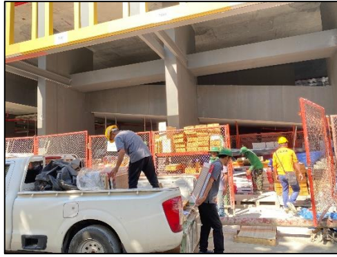
รูปที่ 90 การลงวัสดุก่อสร้างต้องกระทำด้วยความระมัดระวัง และมีวัสดุรองรับเพื่อหลีกเลี่ยงการกระแทก
