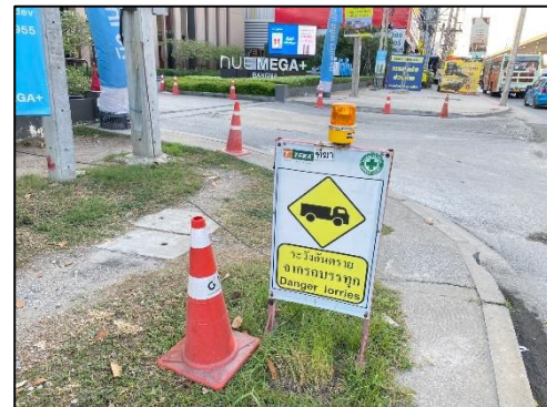
รูปที่ 70 สัญญาณไฟเตือน ไฟกระพริบ และป้ายเตือน ระวังรถบรรทุก เข้า-ออก
