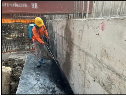
รูปที่ 80 พนักงานทำการบ่มคอนกรีต ด้วยการฉีดพ่นน้ำยา
