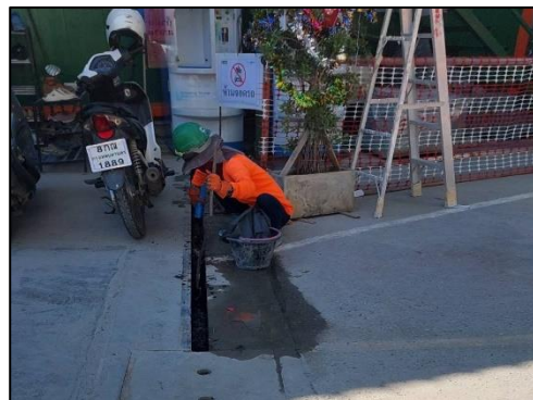
รูปที่ 54 ทำความสะอาดท่อระบายน้ำ
