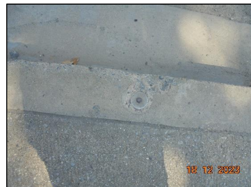
รูปที่ 71 หมุดระดับ และพิกัดอ้างอิงภายในพื้นที่ก่อสร้าง
