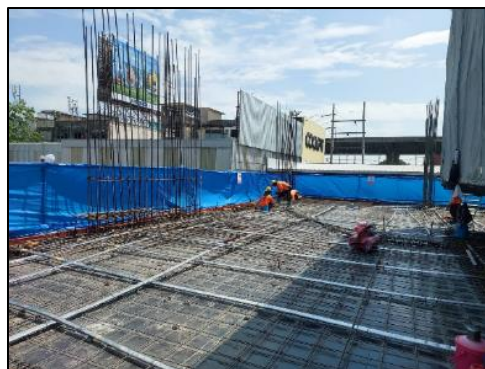
รูปที่ 75 เตรียมพื้นที่ก่อนเทคอนกรีต
