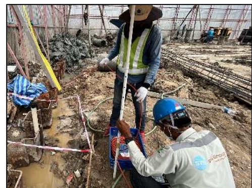
รูปที่ 45 ติดตั้งเครื่องมือตรวจวัดการเอียงตัว
