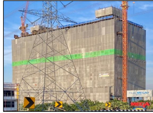
รูปที่ 4 ติดตั้ง Mesh Sheet รอบอาคาร
