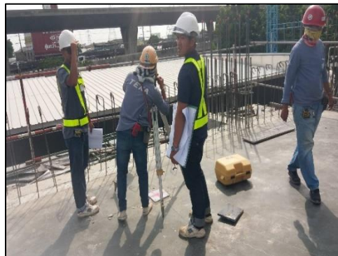
รูปที่ 74 การตรวจสอบระดับความสูงจากระดับอ้างอิงด้วยกล้องวัดมุม (Theodolite หรือ Total Station)
