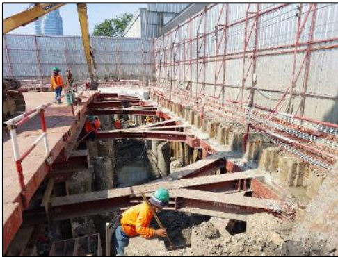
รูปที่ 40 ระบบค้ำยัน และระบบป้องกันดินพัง
