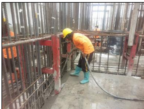
รูปที่ 79 พนักงานฉีดเชย่าคอนกรีต
