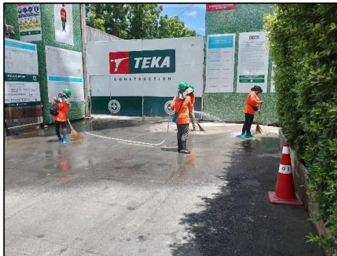
รูปที่ 11 ฉีดพรมน้ำบริเวณพื้นที่ก่อสร้าง หรือบริเวณที่ทำให้เกิดฝุ่น
