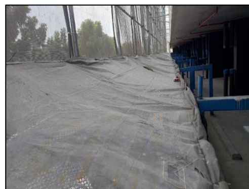
รูปที่ 93 ตะแกรงป้องกันวัสดุตกลงจากตัวอาคาร
