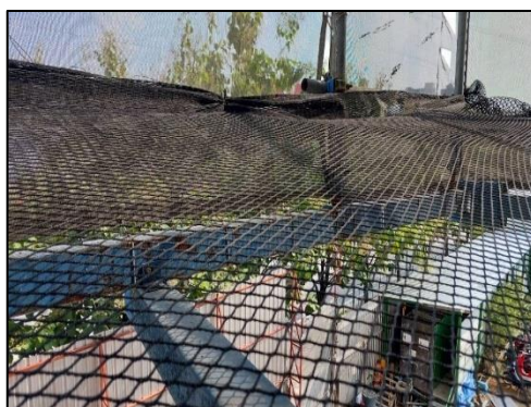
รูปที่ 93 ตะแกรงป้องกันวัสดุตกลงจากตัวอาคาร
