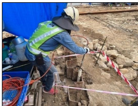
รูปที่ 45 ติดตั้งเครื่องมือตรวจวัดการเอียงตัว
