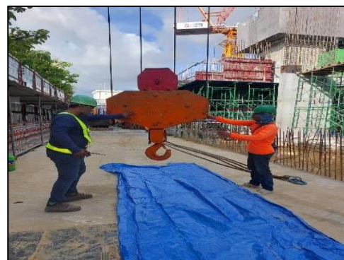
รูปที่ 107 ตรวจสอบส่วนประกอบของอุปกรณ์ของทาวเวอร์เครน
