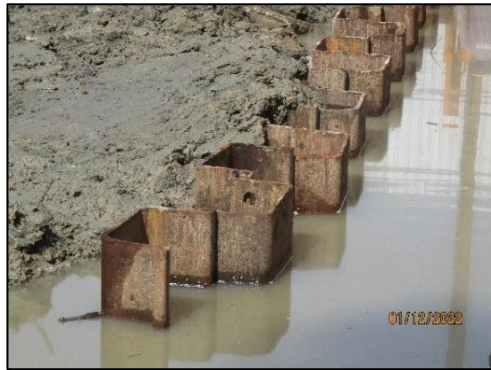
รูปที่ 40 ระบบค้ำยัน และระบบป้องกันดินพัง
