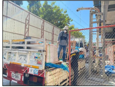
รูปที่ 90 การลงวัสดุก่อสร้างต้องกระทำด้วยความระมัดระวัง และมีวัสดุรองรับเพื่อหลีกเลี่ยงการกระแทก
