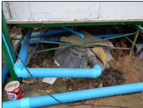
รูปที่ 47 ถังบำบัดน้ำเสียสำเร็จรูป
