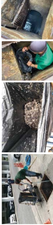
การติดตั้งถังหมักจากระบบบำบัดน้ำเสีย
