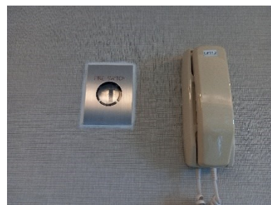
Fireman's Switch Lift และ โทรศัพท์ฉุกเฉิน
