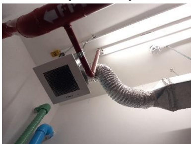
พัดลมระบายอากาศในห้องพักมูลฝอยประจำชั้น
