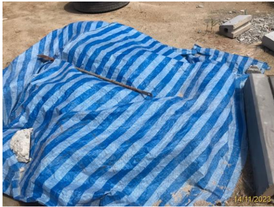
รูปที่ 3-1 กองเก็บดินเป็นสัดส่วน มีผ้าปิดปกคลุม
