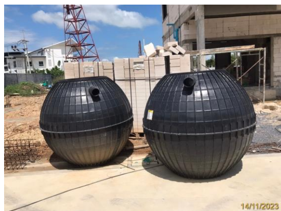
รูปที่ 3-12 ถังบำบัดน้ำเสียสำเร็จรูปแบบเติมอากาศชนิดที่มีตัวกลางยึดเกาะ
