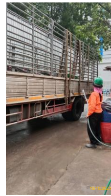
รูปที่ 3-14 ล้างล้อรถก่อนออกนอกพื้นที่โครงการ
