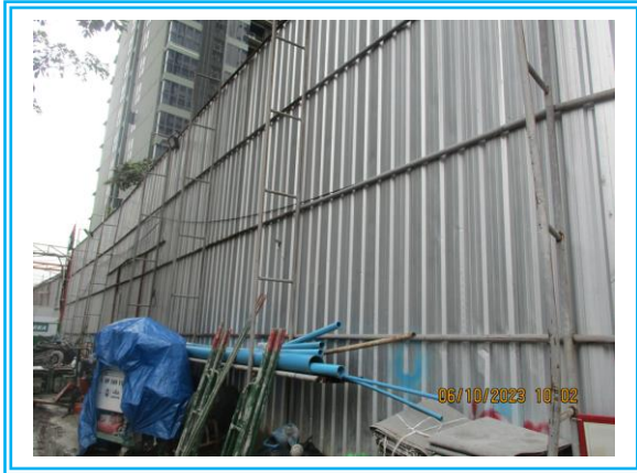
รูปที่ 3-1 รั้ว Metal Sheet ความสูง 6 เมตร โดยรอบพื้นที่ก่อสร้าง
