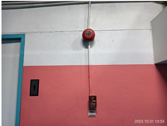
รูปที่ 2.10-1 Fire Manual Station & Fire Alarm Bell
