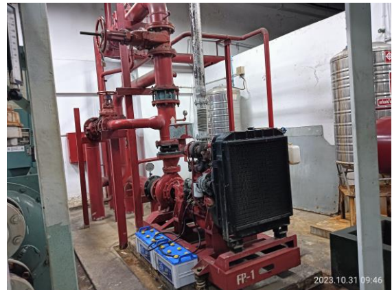
รูปที่ 2.8-4 ปั๊มสูบน้ำดับเพลิง
