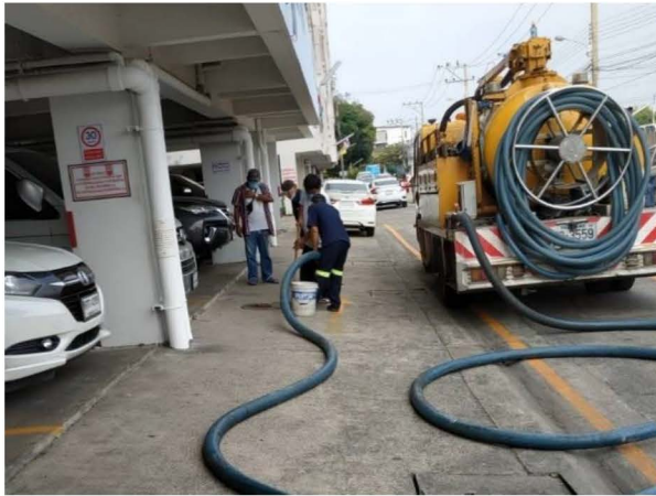
ภาพที่ 3-7 การสูบน้ำจากส่วนเกินเพื่อนำไปกำจัด
