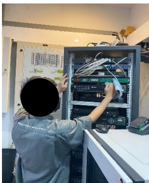
รูปที่ 2-36 ตรวจสอบ ระบบ CCTV รอบโครงการ ทำความสะอาด,ปรับความชัด,ปรับมุมกล้อง
