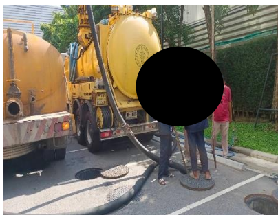
รูปที่ 2-46 สูบตะกอนส่วนเกิน เมื่อวันที่ 13 พฤศจิกายน 2566
