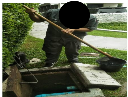
รูปที่ 2-45 ตรวจสอบและทำความสะอาดท่อระบายน้ำ
