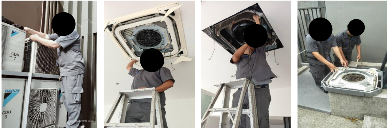
รูปที่ 2-37 ล้างแผ่นกรองและล้างแอร์ส่วนกลาง
