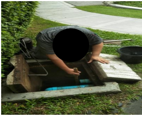
รูปที่ 2-45 ตรวจสอบและทำความสะอาดท่อระบายน้ำ
