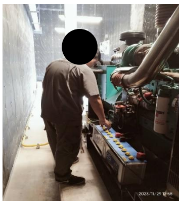
รูปที่ 2-29 เจ้าหน้าที่ตรวจสอบเครื่องกำเนิดไฟฟ้าสำรอง
