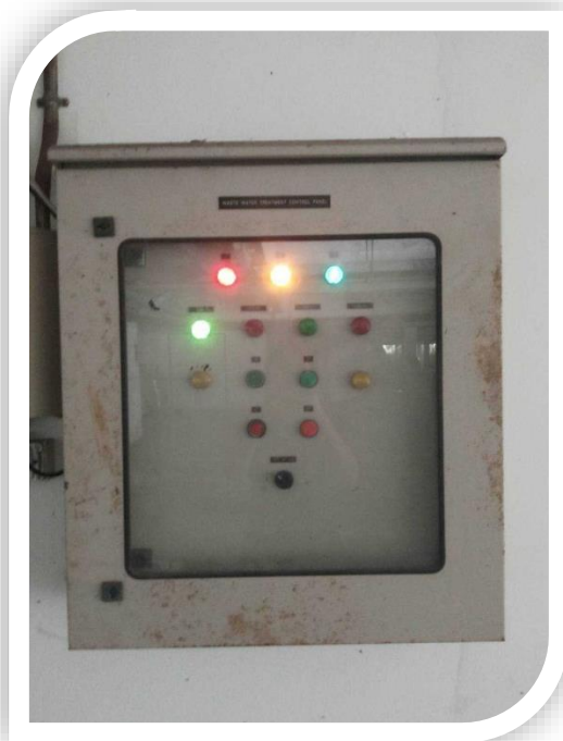
ภาพที่ 11 แสดงตู้คอนโทรลควบคุมการทำงานของเครื่องเดิมอากาศ
