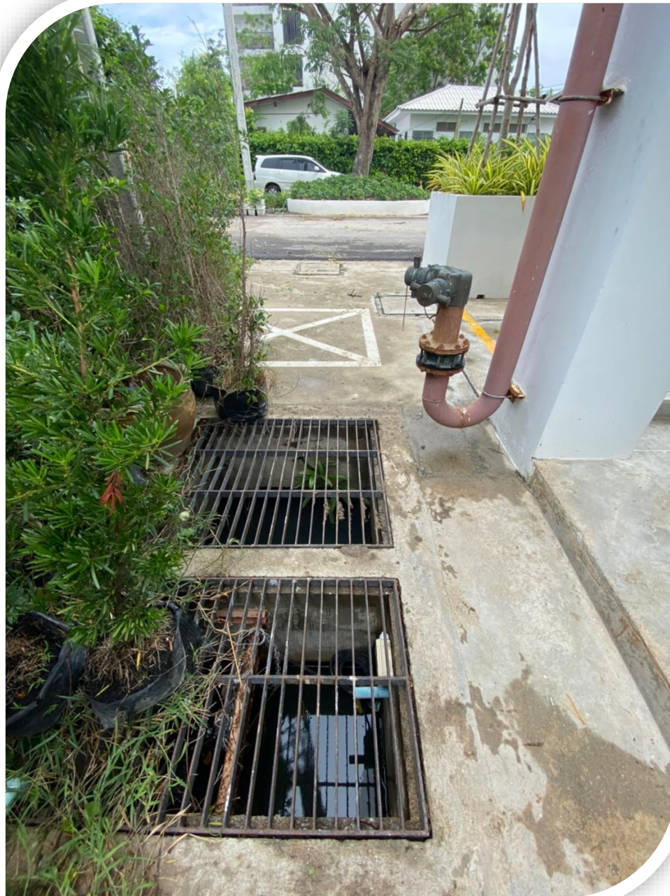
ภาพที่ 15 แสดงบ่อหน่วงน้ำฝนของโครงการ
