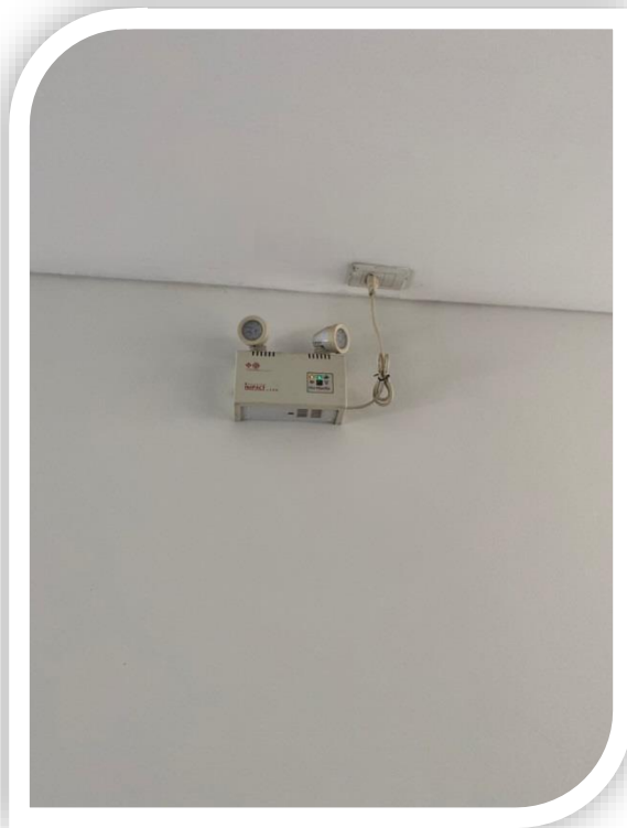
ภาพที่ 27 แสดงไฟส่องสว่างฉุกเฉิน
