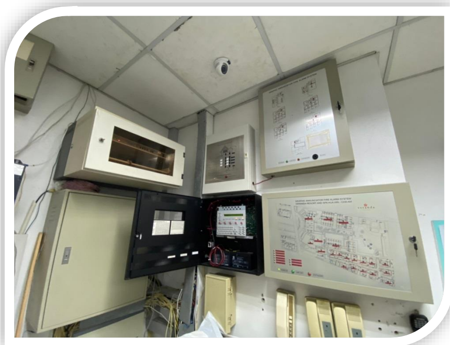
ภาพที่ 23 แสดงผังควบคุมสัญญาณเตือนเพลิงไหม้
