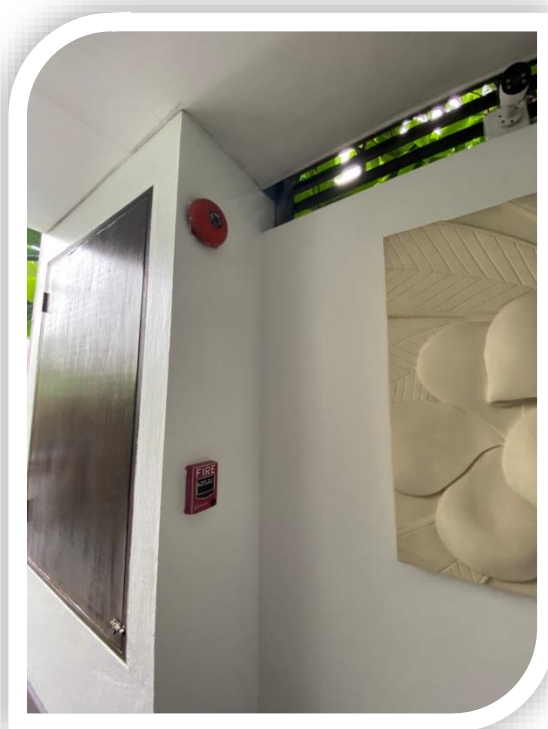
ภาพที่ 18 ระบบสัญญาณแจ้งเหตุเพลิงไหม้
