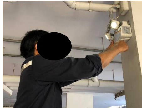
ตรวจเช็คไฟส่องสว่างฉุกเฉิน
