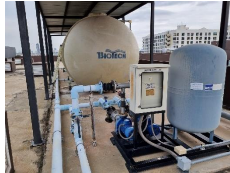
ระบบสูบน้ำใช้ชั้นดาดฟ้า
