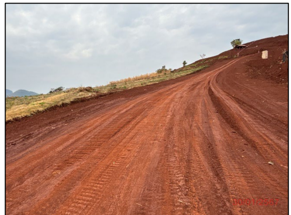
ภาพที่ 2-8 ถนนลูกรังบดอัดแน่นภายในพื้นที่โครงการ
