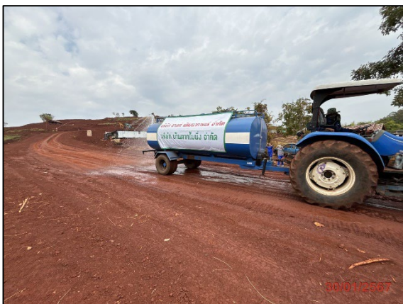
ภาพที่ 2-9 การฉีดพรมน้ำภายในพื้นที่โครงการ
