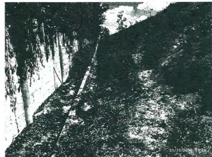
6.ด้านหลัง Green6 มีดินภายในรางน้ำฝนและหญ้าปกคลุม
