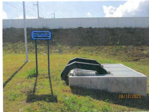
บ่อรวบรวมน้ำเสีย (Lifting Pump Pit)
