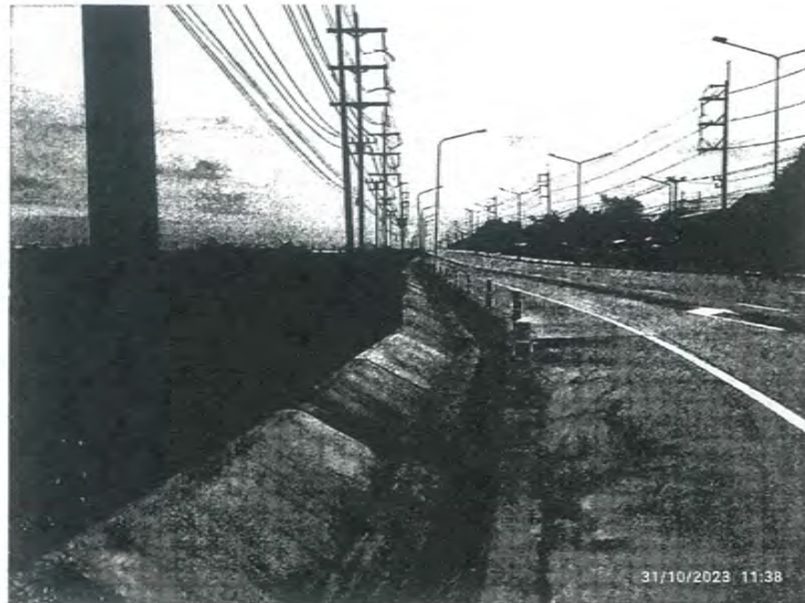
3.ด้านหลังแปลงJ01-J08 มีดินภายในรางน้ำฝนและมีหญ้าปกคลุม
