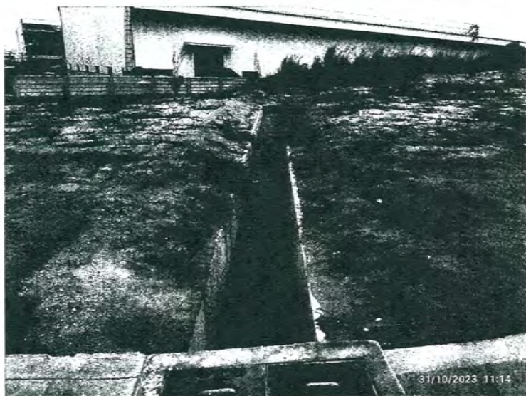
5.ด้านหลังแปลง09-J13 มีดินภายในรางน้ำฝนและหญ้าปกคลุม
