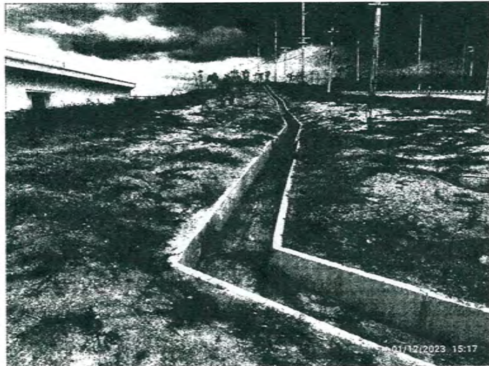
5.ด้านหลังแปลง09 มีดินภายในรางน้ำฝน
