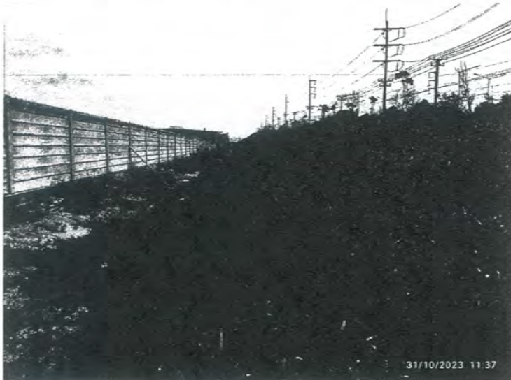
3.ด้านหลังแปลงJ01-J08 มีดินภายในรางน้ำฝนและมีหญ้าปกคลุม
