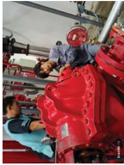
การตรวจสอบ Fire Pump
