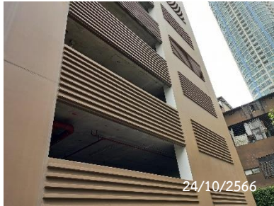
ช่องระบายอากาศของอาคารจอดรถ
