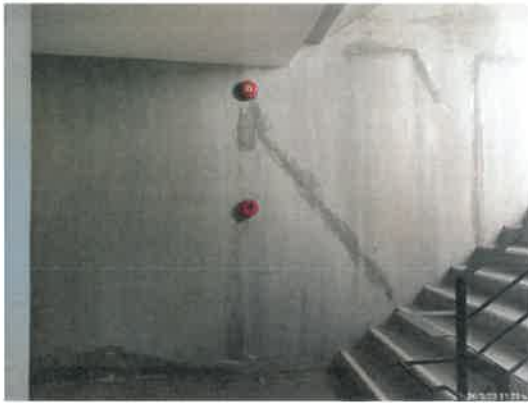
รูปที่ 2-35 แสดงกริ่งสัญญาณเตือนภัย และเครื่องแจ้งเหตุโดยใช่มือกด บริเวณด้านหน้าลิฟต์แต่ละชั้นของโครงการ
