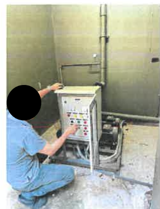
รูปที่ 2-6 แสดงเจ้าหน้าที่เทคนิคดูแลระบบบำบัดน้ำเสีย และสูบน้ำก่อนส่วนเกิน ออกจากระบบบำบัดน้ำเสียภายในโครงการ
