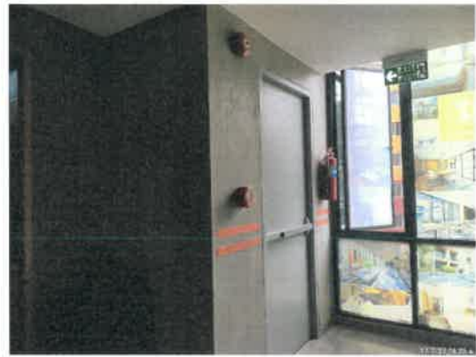
รูปที่ 2-35 แสดงกริ่งสัญญาณเตือนภัย และเครื่องแจ้งเหตุโดยใช่มือกด บริเวณด้านหน้าลิฟต์แต่ละชั้นของโครงการ
