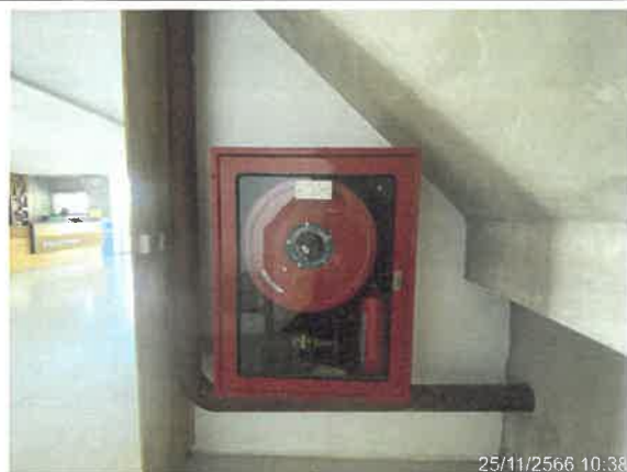
รูปที่ 2-36 แสดงตู้เก็บสายฉีดน้ำดับเพลิง (Fire Hose Cabinet) และถังดับเพลิงแบบมือถือ
