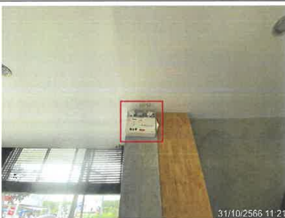
รูปที่ 2-38 แสดงระบบไฟส่องสว่างฉุกเฉิน (Emergency light)
