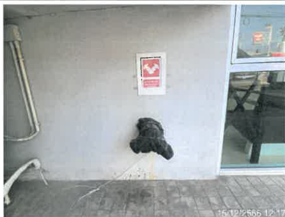
รูปที่ 2-40 แสดงติดตั้งหัวรับน้ำดับเพลิง FDC บริเวณที่จอดรถด้านข้างอาคารโครงการ
