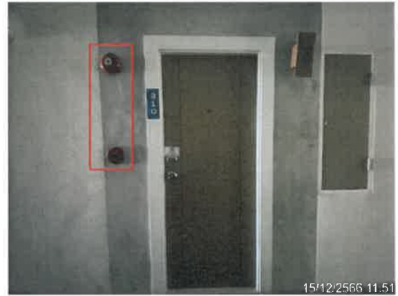
รูปที่ 2-39 แสดงกริ่งสัญญาณเตือนภัย (Alarm Bell) และเครื่องแจ้งเหตุโดยใช้มือถือ (Fire Manual Station Unit)
