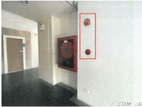
รูปที่ 2-39 แสดงกริ่งสัญญาณเตือนภัย (Alarm Bell) และเครื่องแจ้งเหตุโดยใช้มือถือ (Fire Manual Station Unit)
