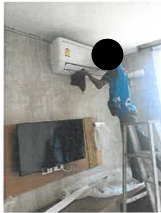
รูปที่ 2-22 แสดงเจ้าหน้าที่ทำความสะอาดเครื่องปรับอากาศภายในโครงการ
