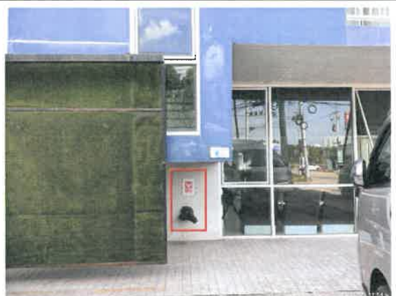
รูปที่ 2-40 แสดงติดตั้งหัวรับน้ำดับเพลิง FDC บริเวณที่จอดรถด้านข้างอาคารโครงการ
