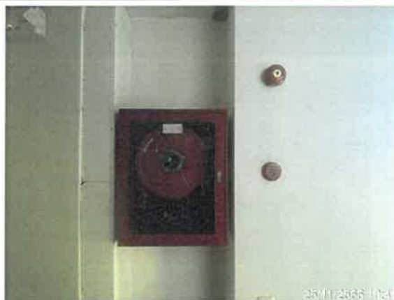
รูปที่ 2-36 แสดงตู้เก็บสายฉีดน้ำดับเพลิง (Fire Hose Cabinet) และถังดับเพลิงแบบมือถือ
