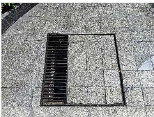
รูปที่ 3-61 ตะแกรงครอบท่อระบายน้ำทิ้ง (ภายนอกอาคาร)
