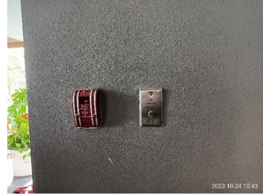
รูปที่ 3-39 ปุ่มกดแจ้งสัญญาณอัคคีภัย (Fire Alarm Manual Station)
