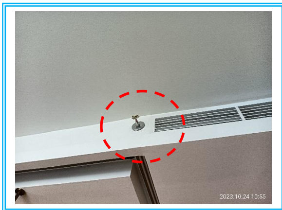
รูปที่ 3-46 หัวกระจายน้ำอัตโนมัติ (Sprinkler)
