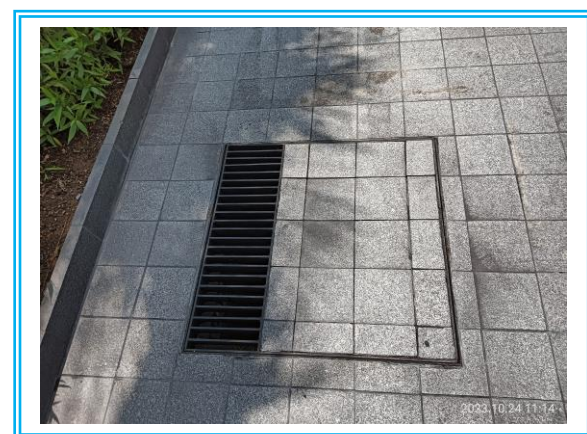
รูปที่ 3-19 ตะแกรงดักมูลฝอยก่อนระบายน้ำออกจากโครงการ
