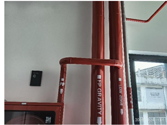
รูปที่ 3-44 ระบบท่อจ่ายน้ำดับเพลิง
