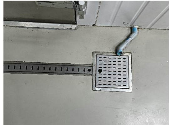
รูปที่ 3-60 ตะแกรงครอบท่อระบายน้ำทิ้ง (ภายในอาคาร)
