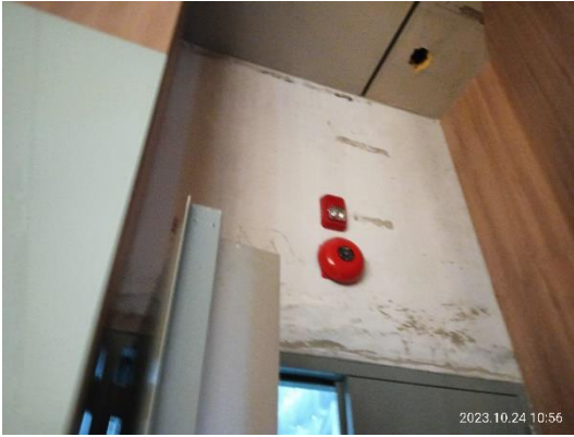
รูปที่ 3-40 สัญญาณแจ้งเหตุ (Alarm Bell)
