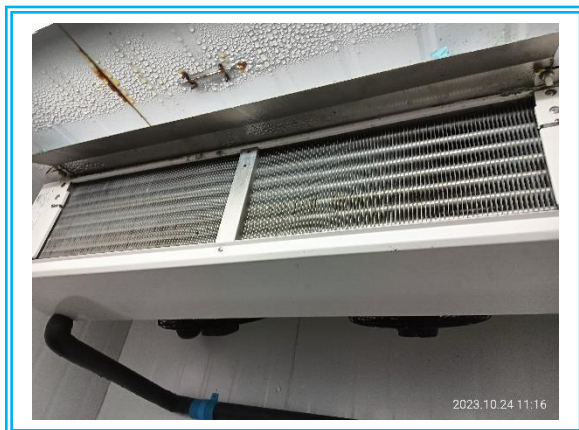
รูปที่ 3-25 ระบบปรับอากาศภายในห้องขยะเปียก (เพื่อป้องกันการเน่าเสีย)
