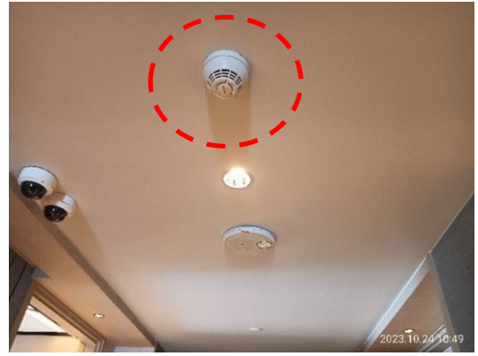
รูปที่ 3-37 เครื่องตรวจจับควัน (Smoke Detector)
