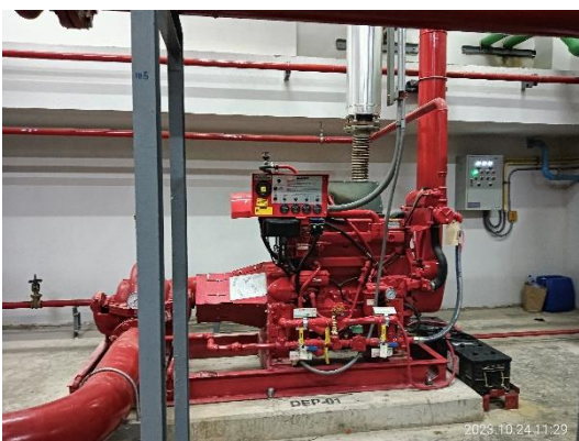
รูปที่ 3-43 เครื่องสูบน้ำดับเพลิง (Fire Pump)
