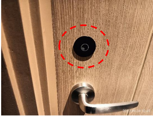
รูปที่ 3-34 ระบบ Access control ด้วยระบบ Keycard
