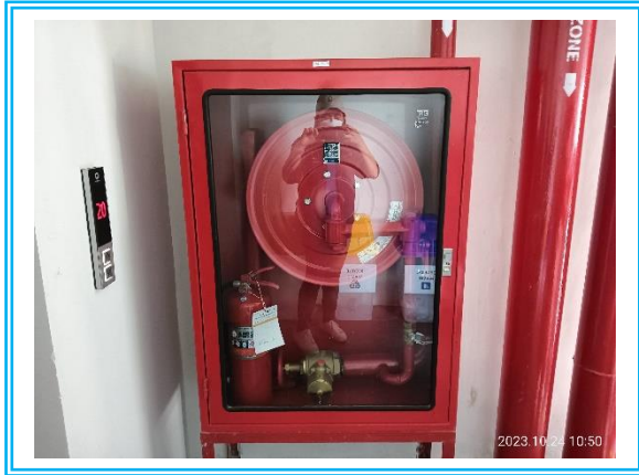
รูปที่ 3-45 ตู้เก็บสายฉีดน้ำดับเพลิง (Fire Hose Cabinet)
