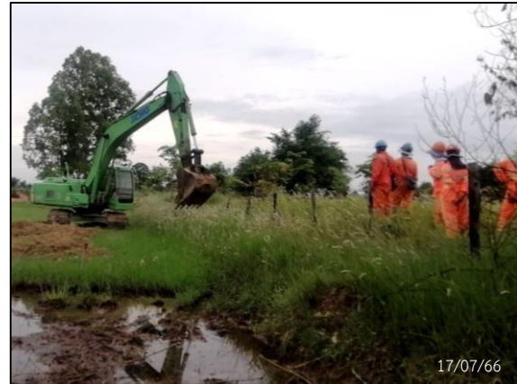
กิจกรรม Clearing และ Grubbing
