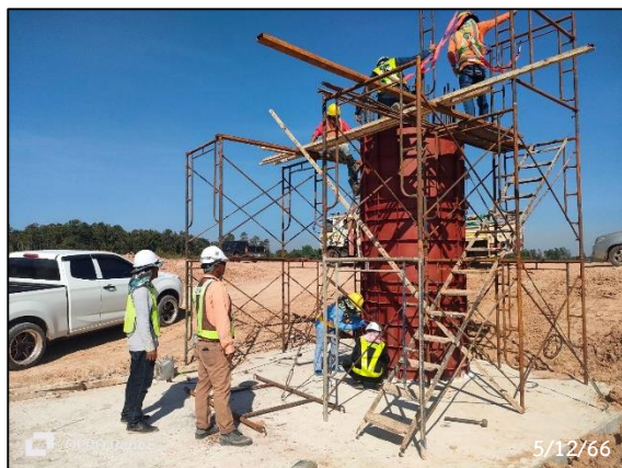
เทคอนกรีตเสาตอม่อสะพานรถไฟ
