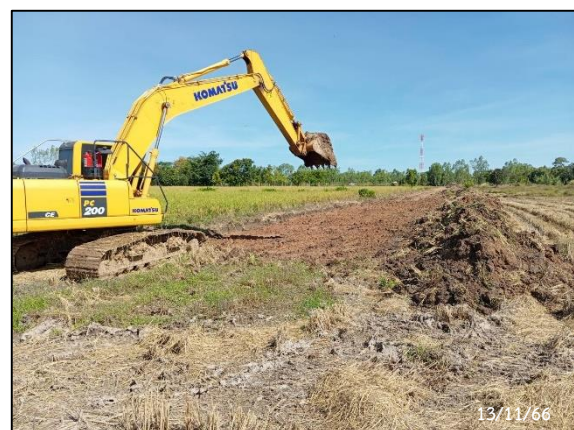
กิจกรรม Clearing และ Grubbing
