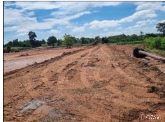
กิจกรรม Clearing และ Grubbing
