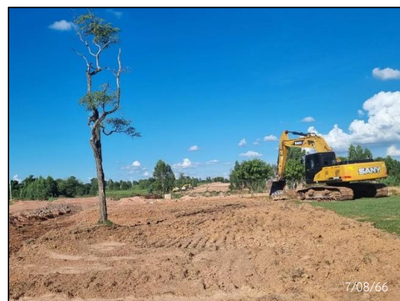
กิจกรรม Clearing และ Grubbing
