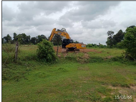
กิจกรรม Clearing และ Grubbing
