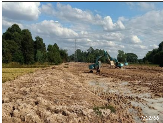
กิจกรรม Clearing และ Grubbing
