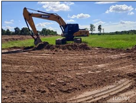
กิจกรรม Clearing และ Grubbing
