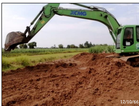
กิจกรรม Clearing และ Grubbing
