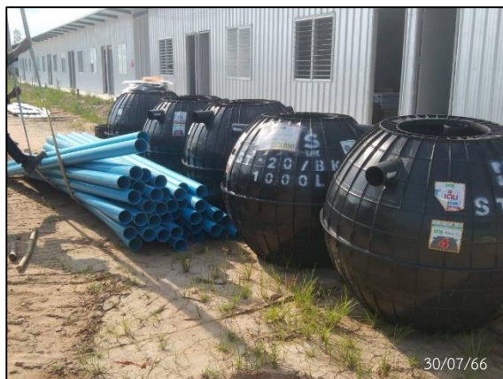
ติดตั้งถังบำบัดน้ำเสียบริเวณสำนักงานก่อสร้างและบ้านพักคนงานก่อสร้าง
