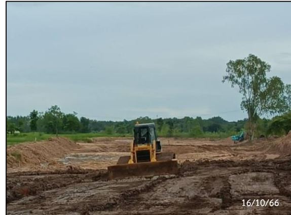
กิจกรรม Clearing และ Grubbing
