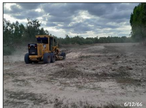
กิจกรรม Clearing และ Grubbing
