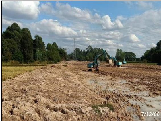
กิจกรรม Clearing และ Grubbing
