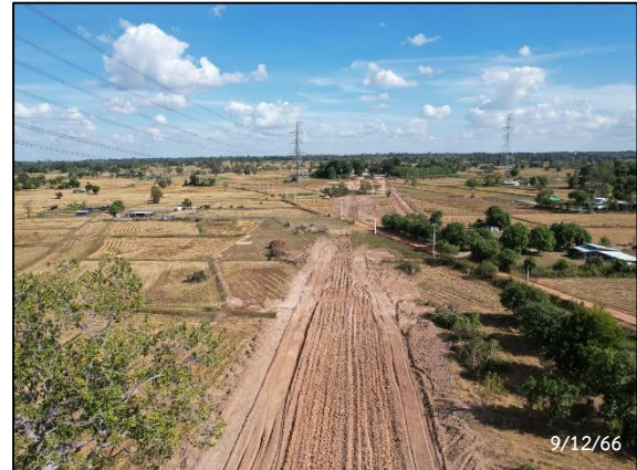
กิจกรรม Clearing และ Grubbing
