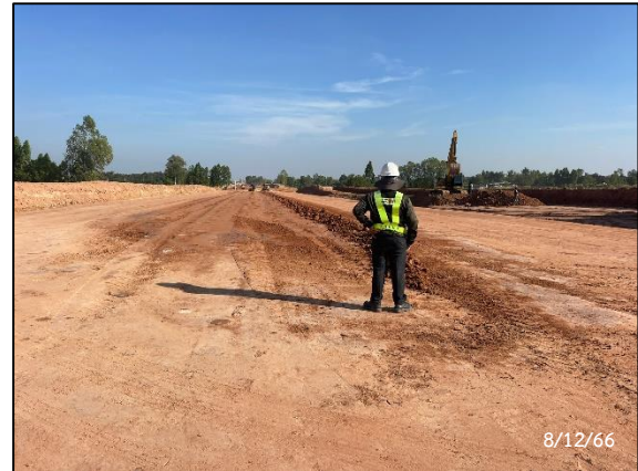
กิจกรรม Clearing และ Grubbing
