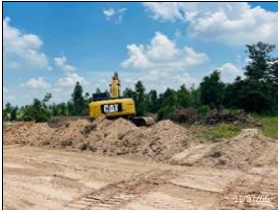
กิจกรรม Clearing และ Grubbing
