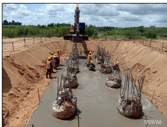
กิจกรรมเทคอนกรีต Footing สะพานรถไฟข้ามลำน้ำยั้ง
