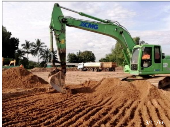
กิจกรรม Clearing และ Grubbing
