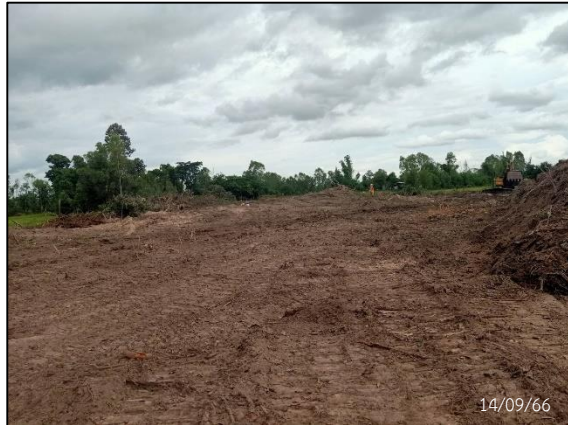
กิจกรรม Clearing และ Grubbing
