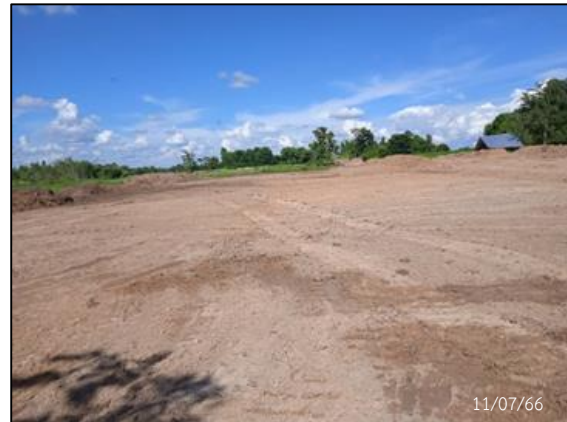
กิจกรรม Clearing และ Grubbing
