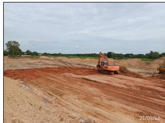
กิจกรรม Clearing และ Grubbing
