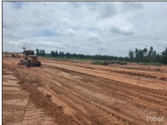
กิจกรรม Clearing และ Grubbing
