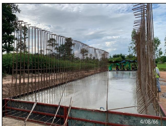
กิจกรรมเทคอนกรีต ผนังทางลอด Box Underpass
