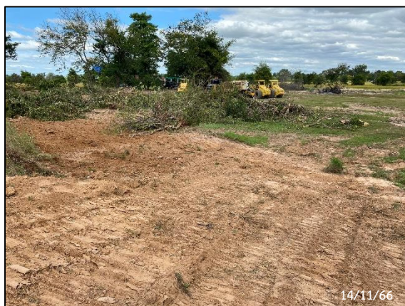
กิจกรรม Clearing และ Grubbing
