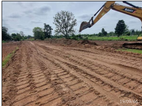
กิจกรรม Clearing และ Grubbing
