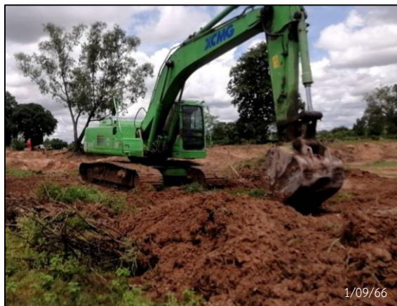
กิจกรรม Clearing และ Grubbing
