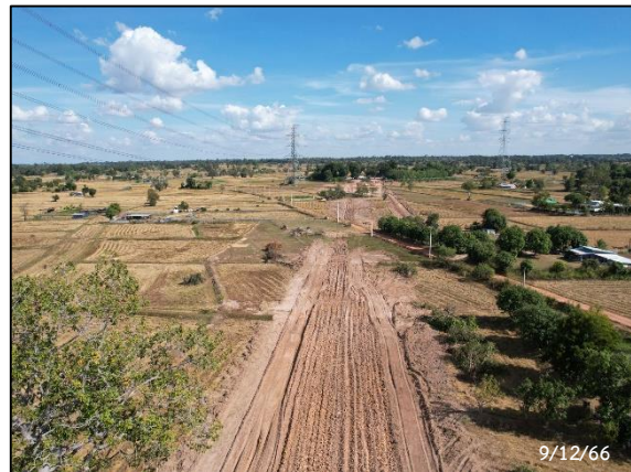
กิจกรรม Clearing และ Grubbing
