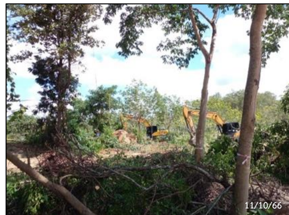
กิจกรรม Clearing และ Grubbing
