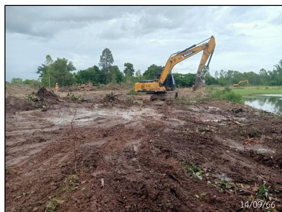
กิจกรรม Clearing และ Grubbing
