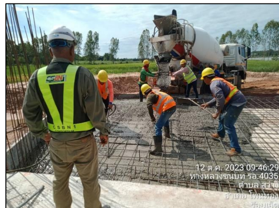
กิจกรรมเทคอนกรีตพื้นทางลอด Box Underpass
