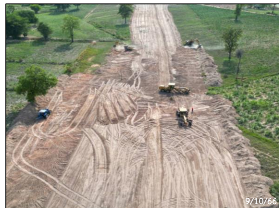
กิจกรรม Clearing และ Grubbing
