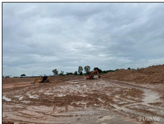
กิจกรรม Clearing และ Grubbing
