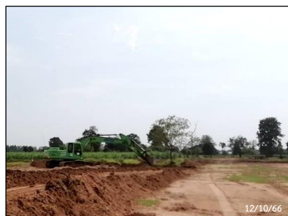
กิจกรรม Clearing และ Grubbing
