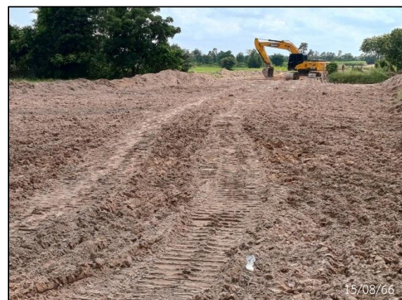
กิจกรรม Clearing และ Grubbing
