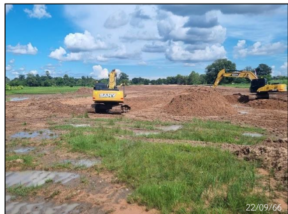
กิจกรรม Clearing และ Grubbing
