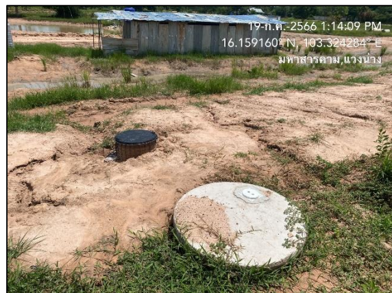
ติดตั้งถังบำบัดน้ำเสียบริเวณสำนักงานก่อสร้างและบ้านพักคนงานก่อสร้าง
