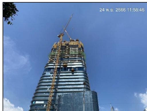
ภาพที่ 115 ควบคุมแขนของเครนให้อยู่ภายในพื้นที่ก่อสร้าง
