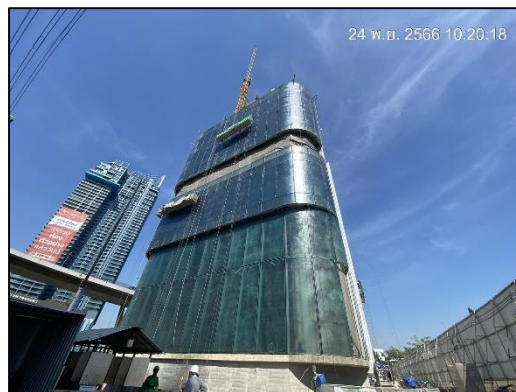
ภาพที่ 124 ติดตั้งแผงกระจกที่ตัวอาคาร
