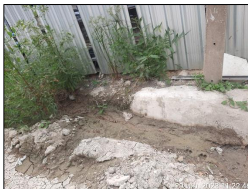
รูปที่ 1-3 รางระบายน้ำชั่วคราวล้อมรอบบริเวณพื้นที่โครงการ
