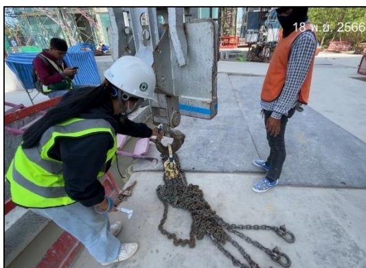
ภาพที่ 24 เจ้าหน้าที่ตรวจสอบเครื่องจักรก่อนนำมาใช้งาน
