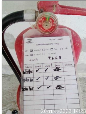
ภาพที่ 44 การตรวจสอบอุปกรณ์ดับเพลิง
