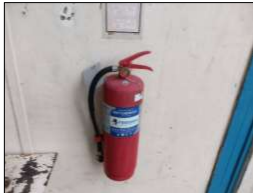
ภาพที่ 58 ถังดับเพลิง และป้ายแนะนำการใช้งาน
