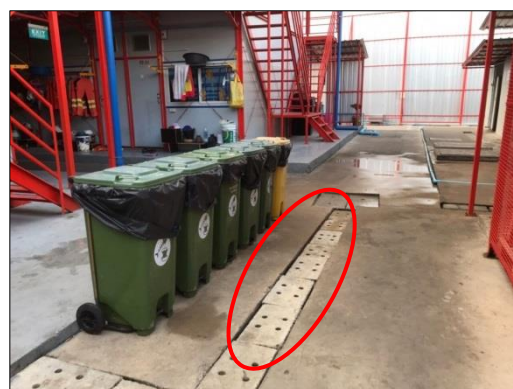
รูปที่ 48 รางระบายน้ำภายในบ้านพักคนงาน
