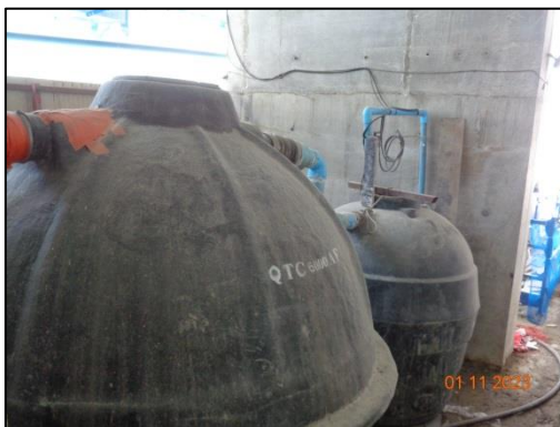
รูปที่ 14 ถังบำบัดน้ำเสียสำเร็จรูป
