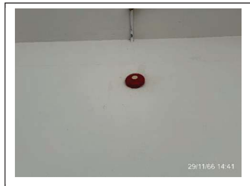
รูปที่ 2.14-9 อุปกรณ์ส่งเสียงสัญญาณแจ้ง เหตุเพลิงไหม้
