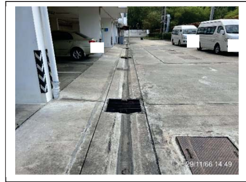
รูปที่ 2.10-2 รางระบายน้ำฝนภายในโครงการ
