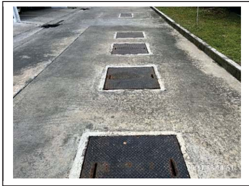
รูปที่ 2.10-1 ระบบระบายน้ำเสียภายในโครงการ
