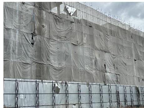
ภาพที่ 2.2-12 ผ้าใบก่อสร้าง (Mesh Sheet)
