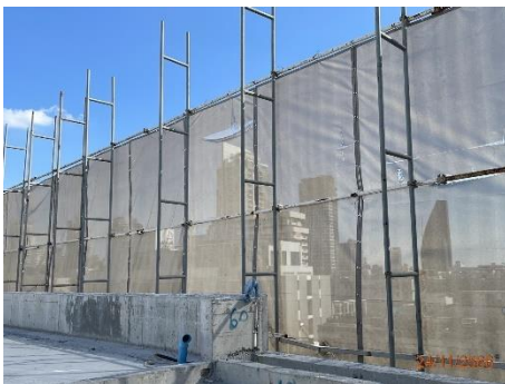
ภาพที่ 2.2-12 ผ้าใบก่อสร้าง (Mesh Sheet)
