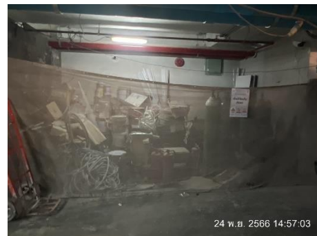
ภาพที่ 2.2-14 การปิดคลุมกองวัสดุก่อสร้าง
