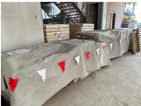
ภาพที่ 2.2-14 การปิดคลุมกองวัสดุก่อสร้าง
