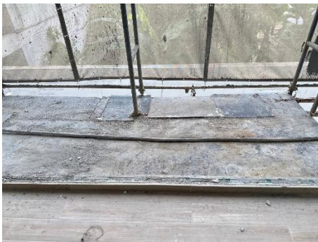
ภาพที่ 2.2-28 การป้องกันวัสดุตกหล่นจากอาคาร
