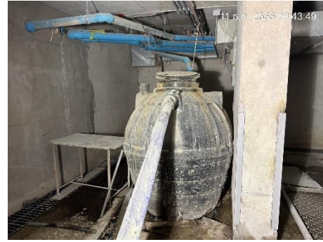
ภาพที่ 2.2-20 ห้องน้ำ และระบบบำบัดน้ำเสียสำเร็จรูปบริเวณพื้นที่โครงการ
