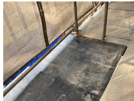
ภาพที่ 2.2-28 การป้องกันวัสดุตกหล่นจากอาคาร
