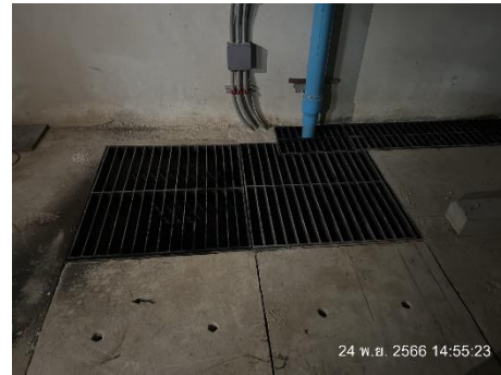
ภาพที่ 2.2-11 รางระบายน้ำ และบ่อพักน้ำภายในพื้นที่โครงการ
