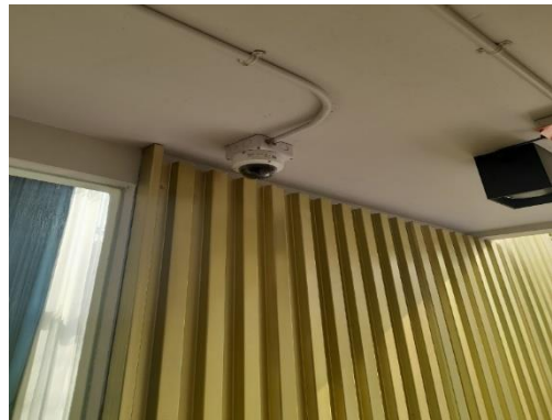
ภาพที่ 5 ระบบกล้องวงจรปิด (CCTV)
