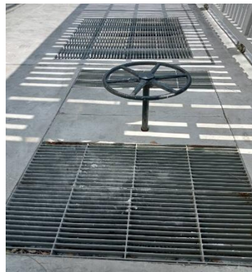
ภาพที่ 18 ระบบบำบัดน้ำเสีย ตะแกรงบ่อบำบัดน้ำเสีย
