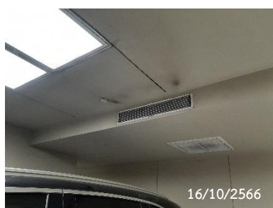
พัดลมระบายอากาศพื้นที่จอดรถ
