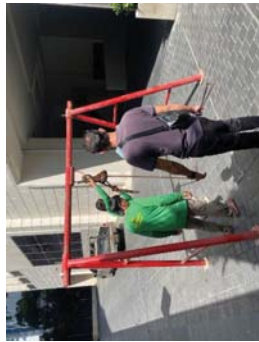
การสูบลบตะกอนบ่อน้ำบาดาลเสีย
