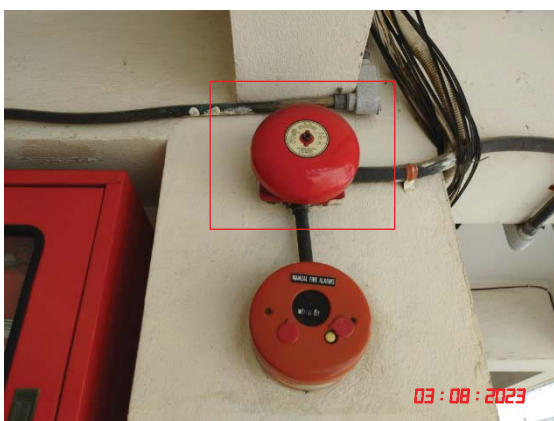
ระบบสัญญาณเตือนภัยแบบกริ่ง
