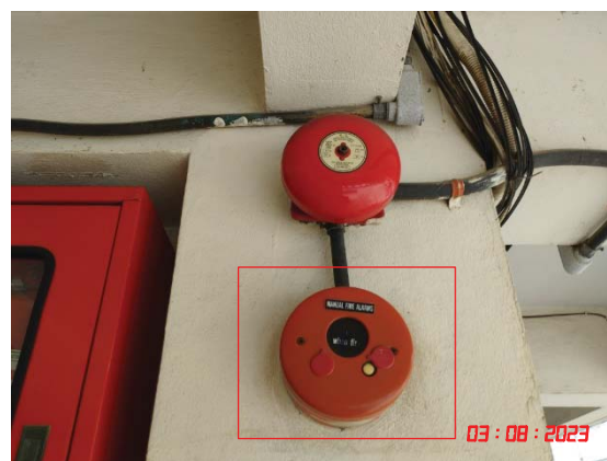
ระบบสัญญาณเตือนภัยแบบใช้มือถือ
