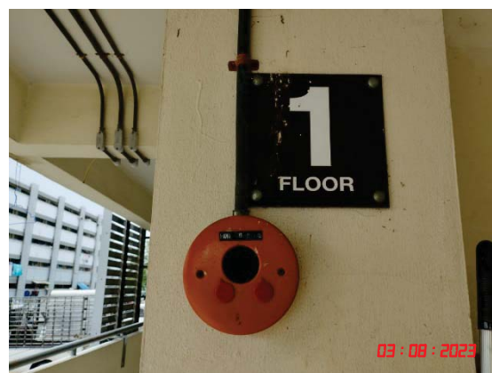
สัญญาณเตือนเพลิงไหม้แบบใช้มือกด
