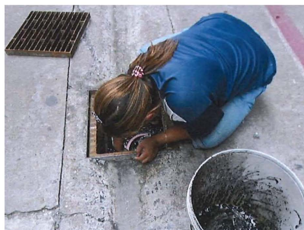
ภาพที่ 2-12 เจ้าหน้าที่ดับไขมันออกจากบ่อ
