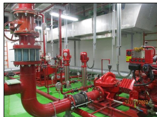
รูปที่ 62 ปั๊มน้ำดับเพลิง (Fire Pump)
