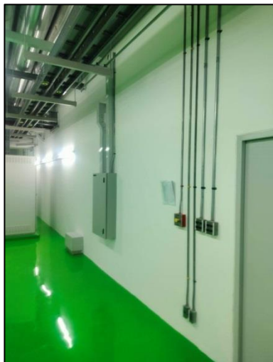
รูปที่ 30 การติดตั้งอุปกรณ์เดินสายไฟฟ้า รวมถึงสายสัญญาณไฟฟ้าสื่อสารต่างๆ
