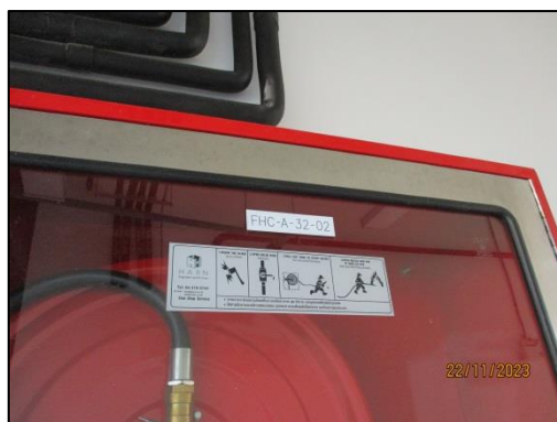
รูปที่ 60 (ต่อ) ตู้เก็บสายฉีดน้ำดับเพลิงพร้อมอุปกรณ์ถังดับเพลิงและป้ายวิธีการใช้
