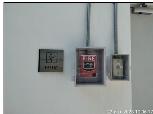
รูปที่ 61 (ต่อ) เครื่องแจ้งเหตุโดยใช่มือ และกริ่งสัญญาณเตือนภัย
