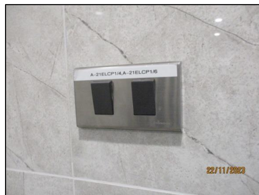
รูปที่ 34 สวิตช์ไฟแยกออกจากกัน สามารถเปิด-ปิดได้เฉพาะจุด
