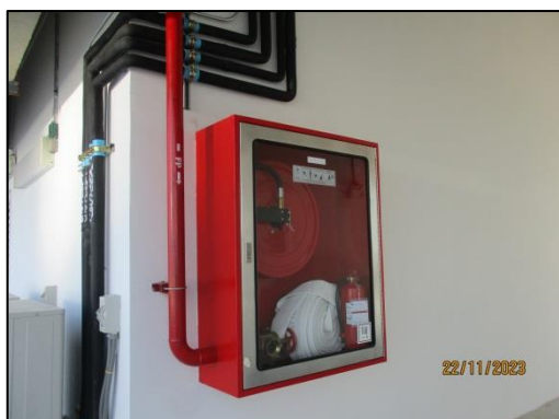
รูปที่ 60 (ต่อ) ตู้เก็บสายฉีดน้ำดับเพลิงพร้อมอุปกรณ์ถังดับเพลิงและป้ายวิธีการใช้
