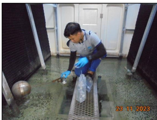
รูปที่ 3.2-1 จุดตรวจวัดคุณภาพน้ำหอผึ่งเย็น บริเวณจุดที่น้ำไหลเข้ามาเติมในระบบ ประจำเดือนกรกฎาคม - ธันวาคม พ.ศ. 2566
