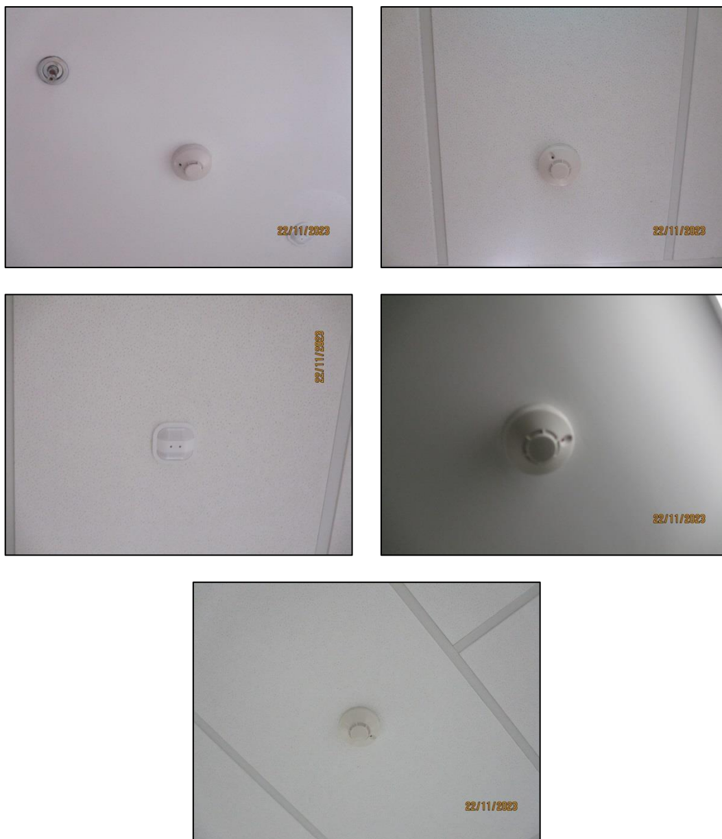
รูปที่ 58 (ต่อ) เครื่องตรวจจับความร้อนและควัน
