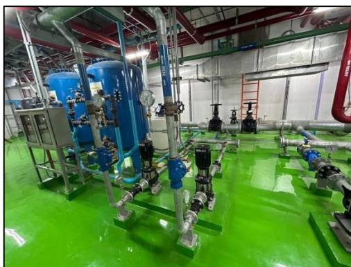
รูปที่ 28 เครื่องสูบน้ำใช้ในโครงการชั้นคาเฟ่และชั้นใต้ดิน
