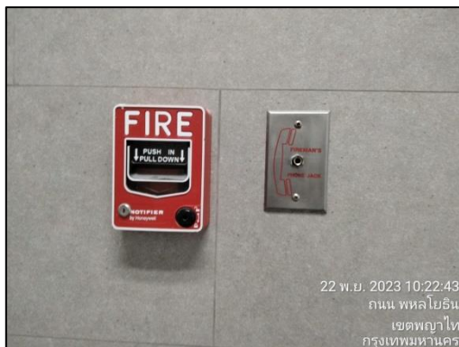
รูปที่ 61 (ต่อ) เครื่องแจ้งเหตุโดยใช่มือ และกริ่งสัญญาณเตือนภัย
