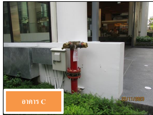
รูปที่ 63 หัวรับน้ำดับเพลิงนอกอาคาร (FIRE DEPARTMENT CONNECTION: FDC)
