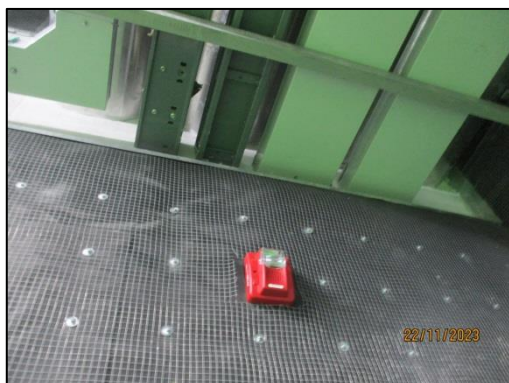
รูปที่ 61 เครื่องแจ้งเหตุโดยใช้มือ และกริ่งสัญญาณเตือนภัย
