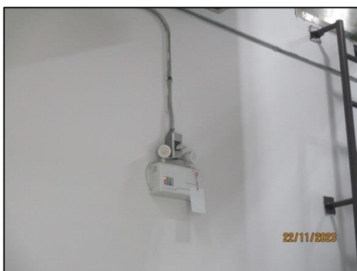
รูปที่ 37 เครื่องไฟฟ้าสำรองและสายไฟ
