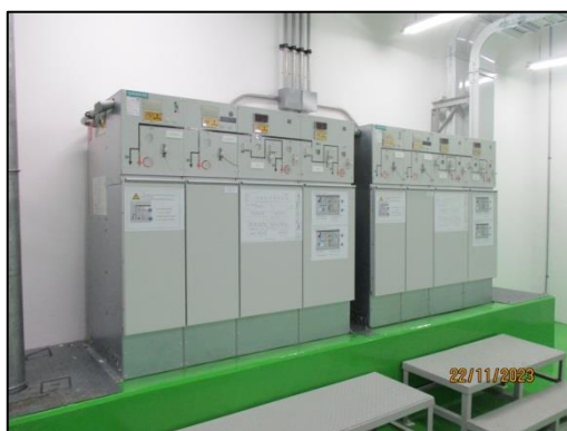
รูปที่ 31 ห้องเครื่องไฟฟ้า (Main Distribution Board: MDB Room)
