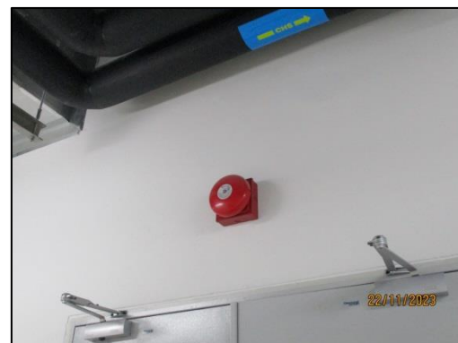
รูปที่ 61 เครื่องแจ้งเหตุโดยใช้มือ และกริ่งสัญญาณเตือนภัย
