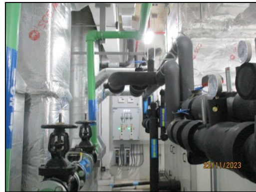
รูปที่ 35 ห้องปรับและหมุนเวียนอากาศ (AHU)
