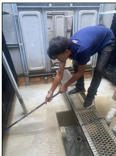
รูปที่ 10 เจ้าหน้าที่ทำความสะอาดหอหล่อเย็น (Cooling Tower) และห้องทำความเย็น (Chiller Room)
