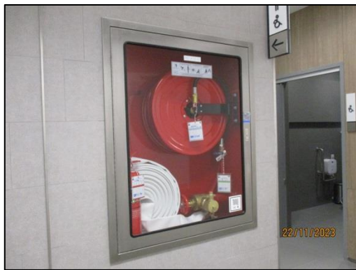
รูปที่ 60 (ต่อ) ตู้เก็บสายฉีดน้ำดับเพลิงพร้อมอุปกรณ์ถังดับเพลิงและป้ายวิธีการใช้
