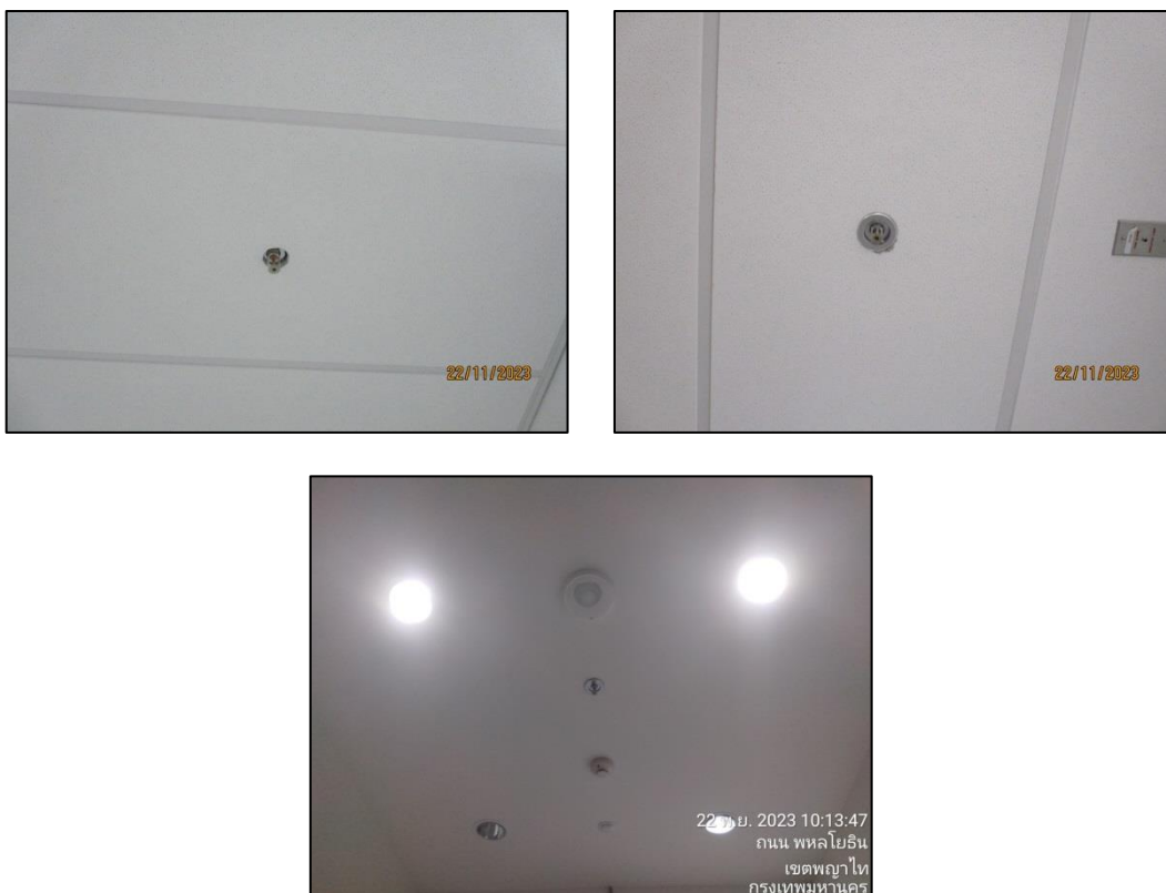
รูปที่ 59 ระบบหัวกระจายน้ำดับเพลิงอัตโนมัติ
