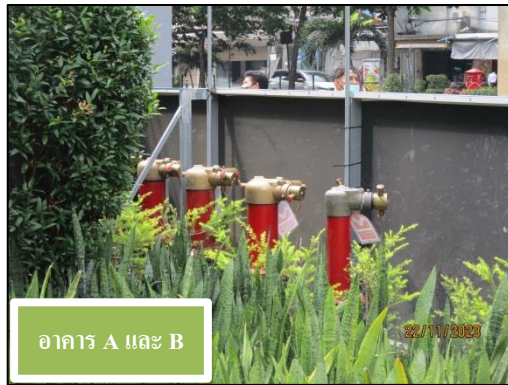
รูปที่ 63 หัวรับน้ำดับเพลิงนอกอาคาร (FIRE DEPARTMENT CONNECTION: FDC)
