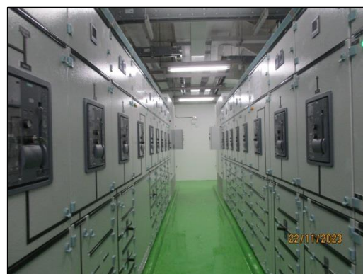
รูปที่ 31 ห้องเครื่องไฟฟ้า (Main Distribution Board: MDB Room)
