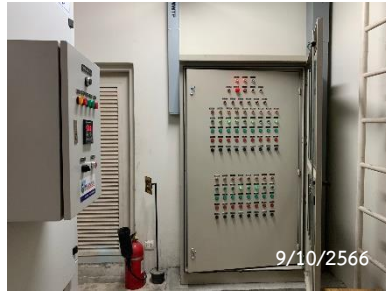
ตู้ควบคุมระบบบําน้ำเสียอาคารพักอาศัย
