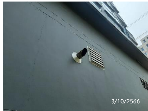
ท่อระบายไอเสียห้อง Generator Room
