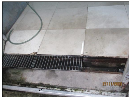
รูปที่ 36 รางระบายน้ำภายในห้องพัสดุส่วนกลาง
