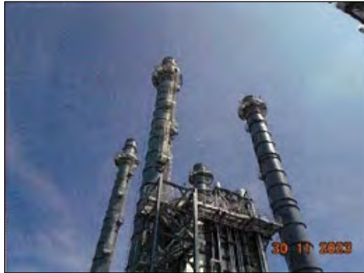
ภาพที่ 2-2 โรงงานที่มีการปล่อยมลพิษทางอากาศต้องก่อสร้างปล่องสูงไม่น้อยกว่า 60 ม.
