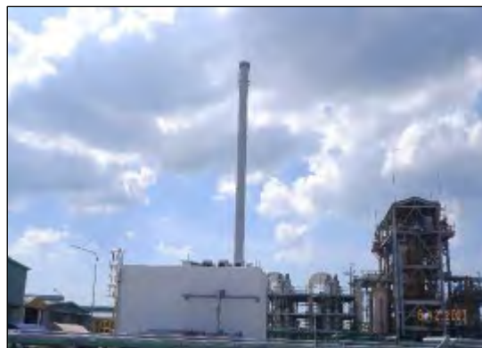
ภาพที่ 2-3 การติดตั้งอุปกรณ์ Flare (ปล่องเผาก๊าซหรือสารเคมี)
