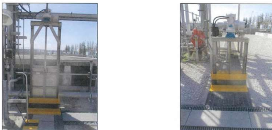
ภาพที่ 2.2-36 การติดตั้งประตูกั้นน้ำบริเวณรางระบายน้ำฝนบนเขื่อนก่อนเข้าบ่อพักน้ำฝนบนเขื่อน
