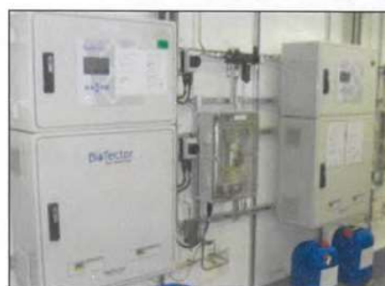
ภาพที่ 2.2-9 อุปกรณ์ตรวจวัดคุณภาพน้ำอัตโนมัติ
