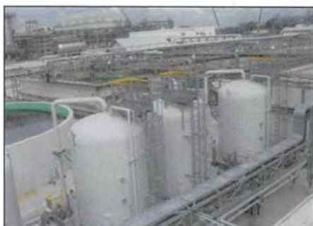
ภาพที่ 2.2-8 ระบบบำบัดน้ำเสียแบบเอเอส
