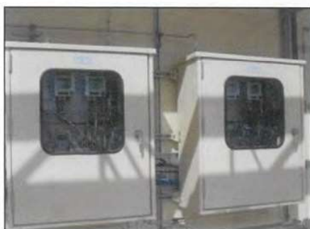
ภาพที่ 2.2-9 อุปกรณ์ตรวจวัดคุณภาพน้ำอัตโนมัติ
