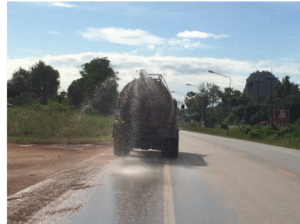
รูปที่ 2-18: การฉีดพรมน้ำบนเส้นทางขนส่งแร่
