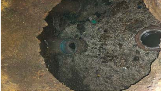
การสูบลบตะกอนจากระบบบำบัดน้ำเสีย
