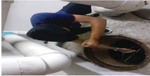
การตัดไก่เหม็นออกจากบ่อดักไก่เหม็น
