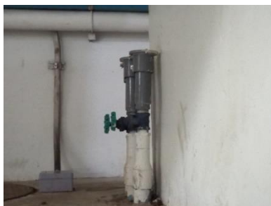
ท่อระบายอากาศระบบบำบัดน้ำเสีย
