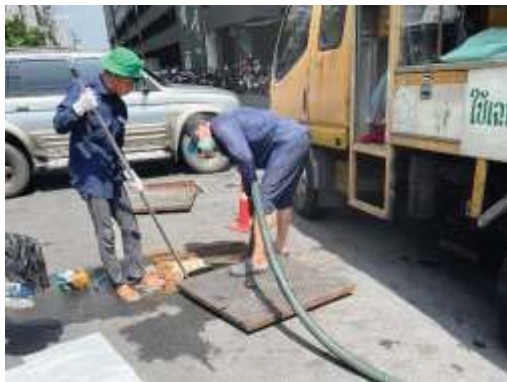
สูบลตะกอน และไขมันจากระบบบำบัดน้ำเสีย
