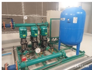
Booster Pump ชั้นดาดฟ้า
