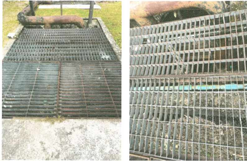
รูปภาพที่ 2.14 ตะแกรงดักขยะ
