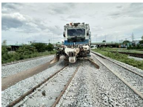
วางหมอนหมอนคอนกรีต และวางรางรถไฟ
