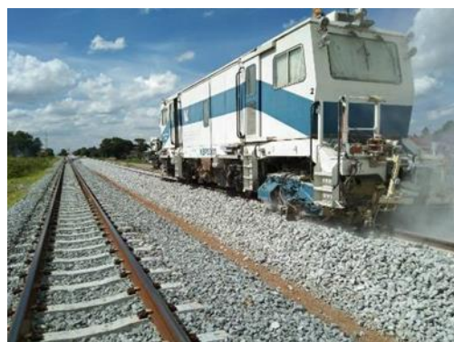
วางหมอนหมอนคอนกรีต และวางรางรถไฟ
