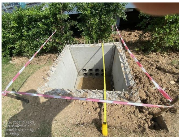
งานก่อสร้าง Main Cable Pit
