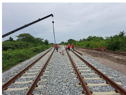
วางหมอนหมอนคอนกรีต และวางรางรถไฟ
