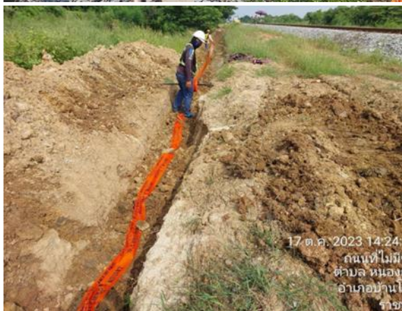
งานก่อสร้าง Cable Trench and Laying Cabel
