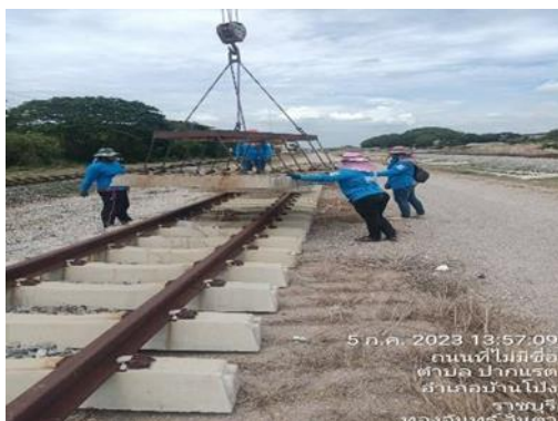
วางหมอนหมอนคอนกรีต และวางรางรถไฟ
