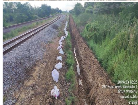
งานก่อสร้าง Cable Trench and Laying Cabel
