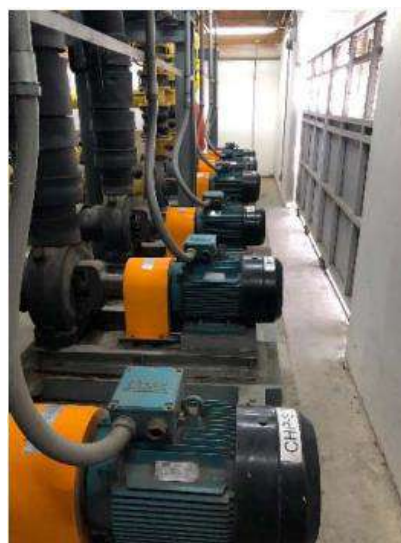
รูปที่ 4 อุณหภูมิใช้งาน และปั๊มน้ำเย็น(CHP)
