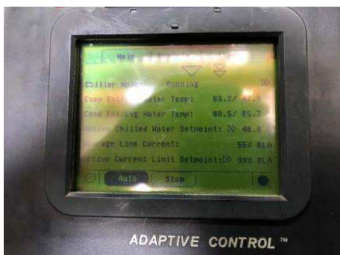
รูปที่ 4 อุณหภูมิใช้งาน และปั๊มน้ำเย็น(CHP)
