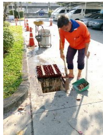
ภาพที่ 2.2-12 เก็บกวาดเศษขยะบริเวณตะแกรงดักขยะก่อนเข้าสู่บ่อท่วงน้ำฝนและก่อนระบายออกสู่ภายนอกโครงการ
