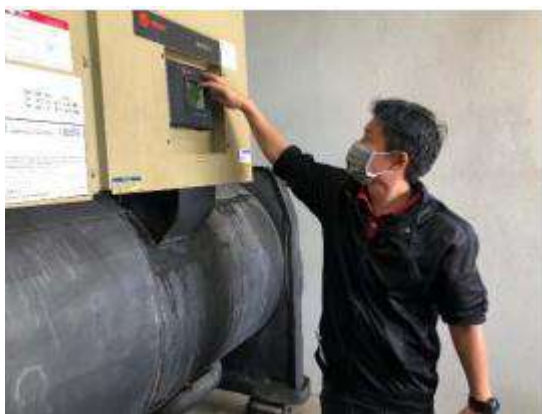
รูปที่ 5 ตรวจสอบอุณหภูมิอัตราการไหลกำลังไฟฟ้า และค่าความแตกต่างของแรงดันน้ำ
