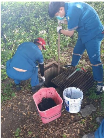
ภาพที่ 2.2-10 ขุดลอกเศษตะกอนในท่อระบายน้ำและบ่อพักน้ำ
