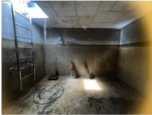
ภาพที่ 2.2-34 ขั้วล่างทำความสะอาดถังเก็บน้ำใช้
