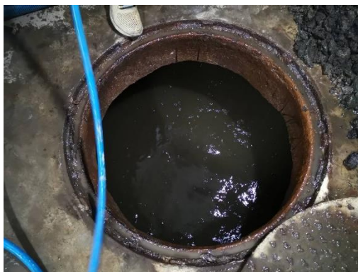
ภาพที่ 2.2-8 สูบตะกอนในถังเก็บตะกอนจากระบบบำบัดน้ำเสีย
