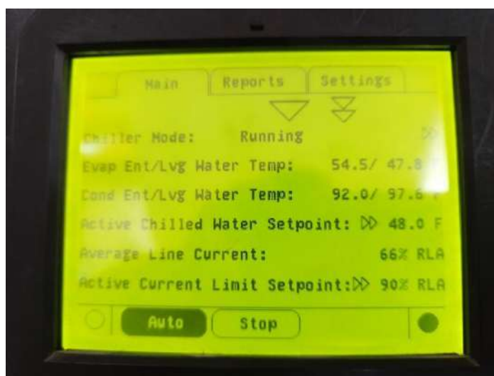
รูปที่ 7 หน้าจอแสดงผลอุณหภูมิน้ำเย็นของ Chiller
