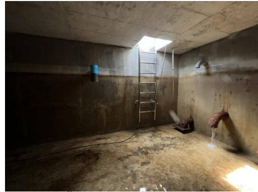
ภาพที่ 2.2-34 ขั้วล่างทำความสะอาดถังเก็บน้ำใช้
