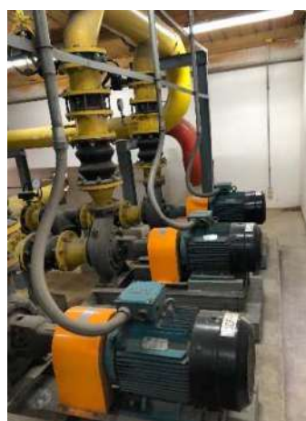
รูปที่ 8 อุณหภูมิใช้งาน และปั๊มน้ำหล่อเย็น(CDP)
