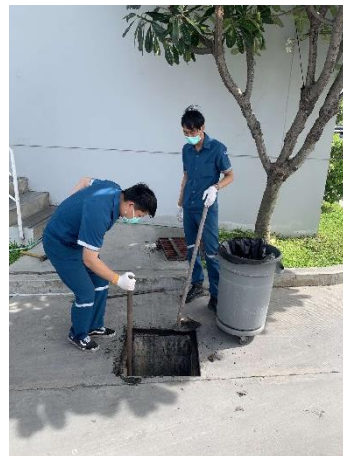
ภาพที่ 2.2-10 ขุดลอกเศษตะกอนในท่อระบายน้ำและบ่อพักน้ำ
