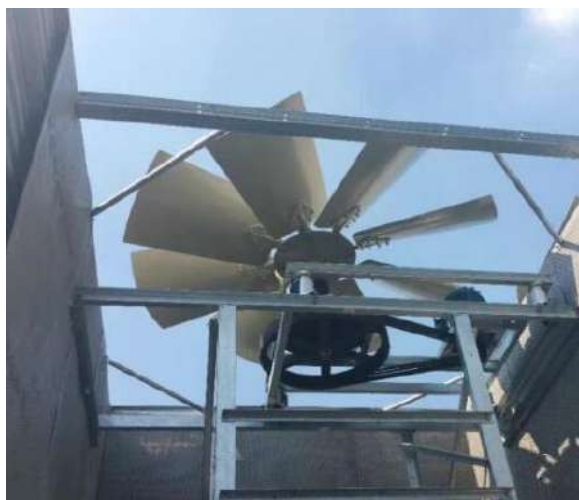
รูปที่ 13 พัดลมระบายอากาศก่อนปรับปรุง
