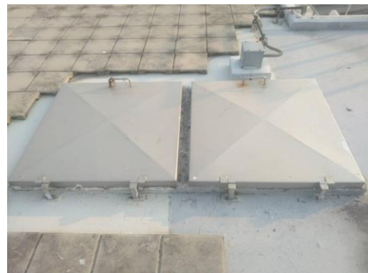
ภาพที่ 2.2-35 ถังเก็บน้ำสำรองที่มีฝาดังจำนวน 2 ฝาด
