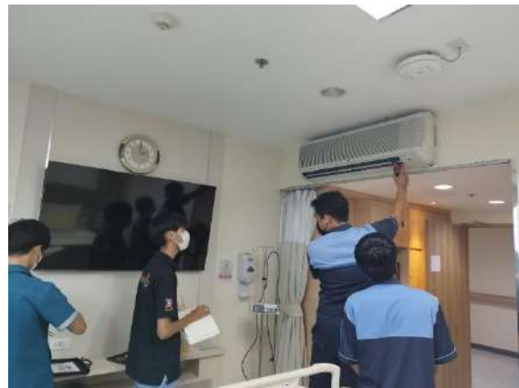
รูปการตรวจวัดลมแอร์และอุณหภูมิต่างๆ
