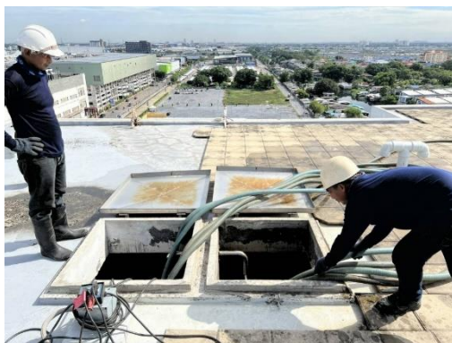
ภาพที่ 2.2-34 ขัดล้างทำความสะอาดถังเก็บน้ำใช้
