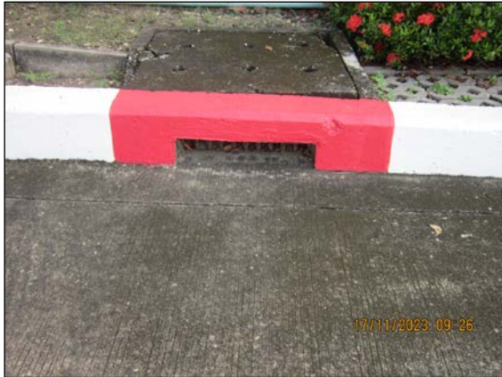
ภาพที่ 2.2-12 ตะแกรงดักขยะบริเวณท่อระบายน้ำ
