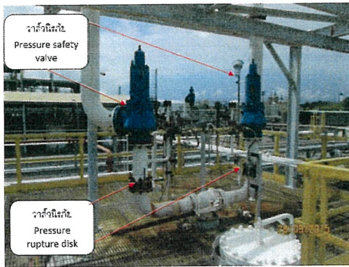
วาล์วนิรภัย และอุปกรณ์ระบายความดัน (Rupture Disc) ป้องกันระบบถึงปฏิกิริยา
