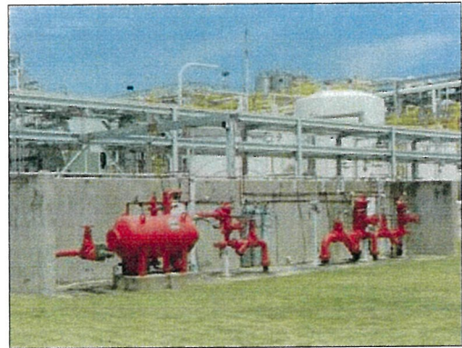
ถังเก็บโฟมและระบบจ่ายโฟม
