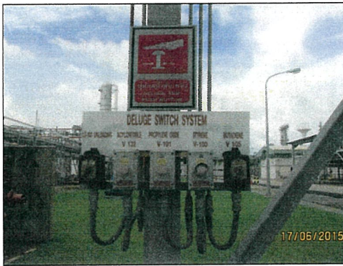
ปุ่มกดน้ำดับเพลิง บริเวณถังเก็บวัตถุดิบ
