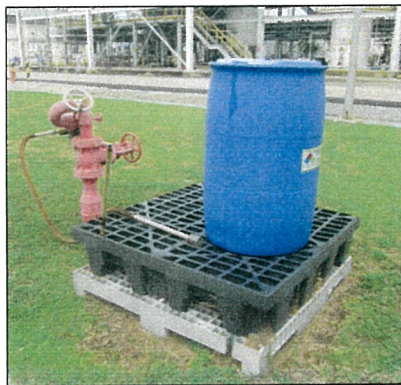
ปืนฉีดน้ำดับเพลิง และโฟมดับเพลิง บริเวณถังเก็บวัตถุดิบ
