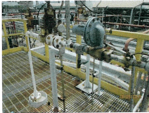
วาล์วควบคุมความดัน Pressure Control Valve
