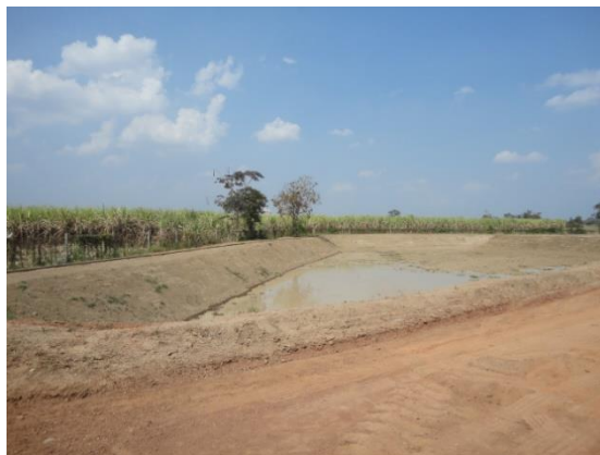
ภาพถ่ายที่ 2.2-2 บ่อเก็บเศษหินเศษดิน (Top Hole Cutting Pit)
