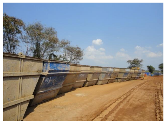
ภาพถ่ายที่ 2.2-3 เศษดินเศษหินในกล่องเหล็ก (Lugger Box) และมีวัสดุปิดคลุม
