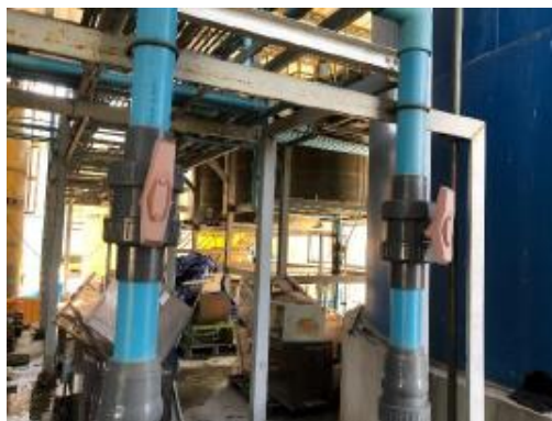
ภาพที่ 2-22 การติดตั้งวาล์วเปิด-ปิด เพื่อควบคุมการปล่อยน้ำเสียของโรงงาน
