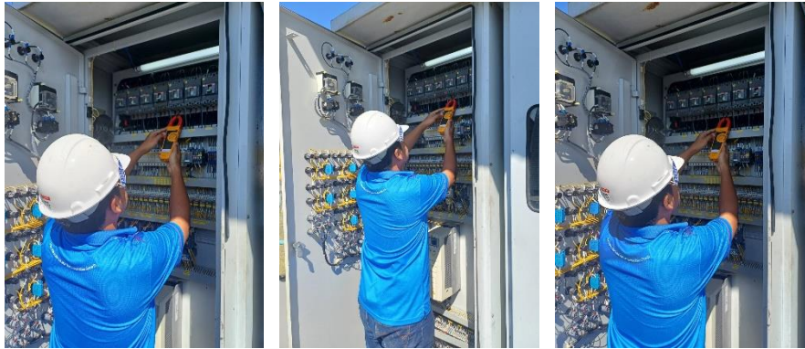
ภาพที่ 2-11 พนักงานตรวจสอบอุปกรณ์ไฟฟ้าที่ระบบบำบัดน้ำเสีย
